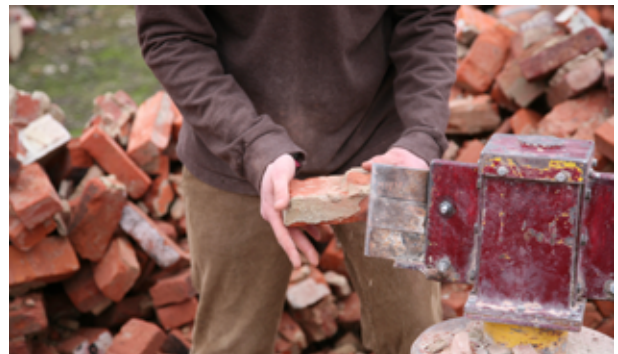
Handmatige en mechanische reiniging van mortelresten
