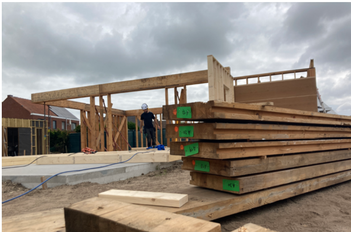
Voorbeeld: markeringen aangebracht op gelamelleerde houten liggers © HuisMus - Trovo
