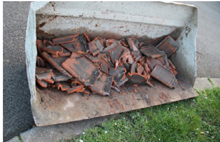
Voorbeeld van het uitsorteren van niet-herbruikbare reststukken van dakpannen bij demontage
