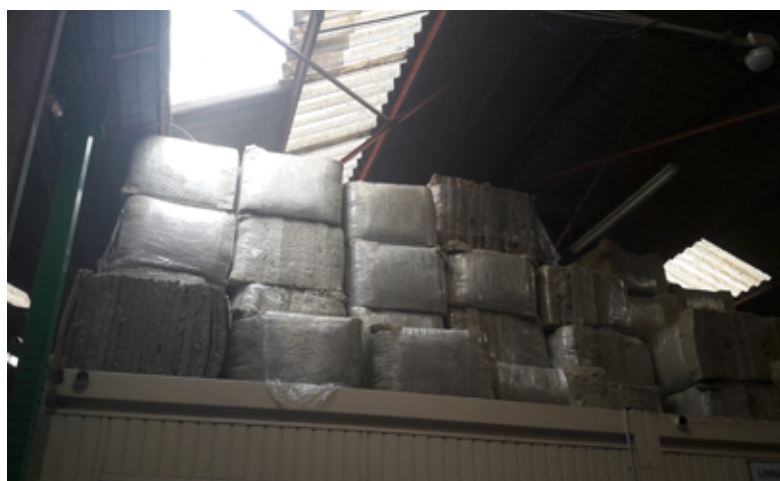
Opslag van minerale wol van binnenwanden, voordat deze opnieuw wordt geplaatst als isolatie van hellende daken
