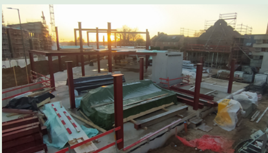
Chantier Mundo Lab à Louvain-La-Neuve, Belgique
