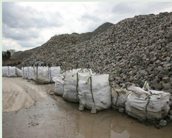
Stockage sur site des pavés.
