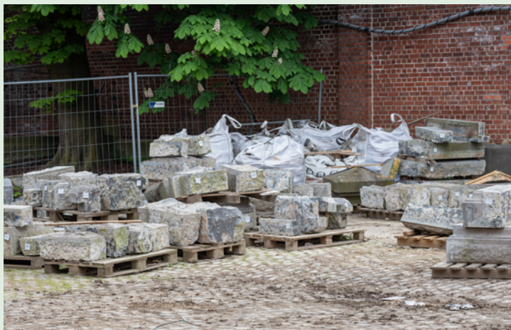
Stockage d'éléments en pierre déposés Caserne d'Ixelles © Ekkow Photography - Buildwise
