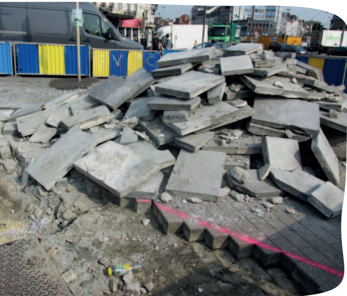
Chantier de voirie à Bruxelles, septembre 2020. Des dalles de sol en pierre bleue sont démontées sans soin particulier : par cette action, l'entrepreneur se défait des matériaux et les transforme juridiquement en déchet.
