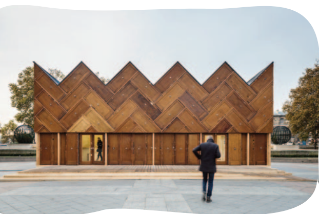
Pavillon circulaire, Encore Heureux. Photographes : Cyrus Cornut + Florence Morisson (chantier).
