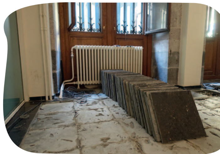
Démontage d'un dallage en pierre naturelle, Anvers 2018. Ce dallage a été identifié dans un inventaire du potentiel de réemploi des éléments présents dans un bâtiment public. Il fait l'objet d'une dépose ciblée effectuée par un acteur spécialisé, qui assurera également sa revente sur un marché bien établi. Le faisceau d'indices converge clairement du côté de la catégorie produit.
