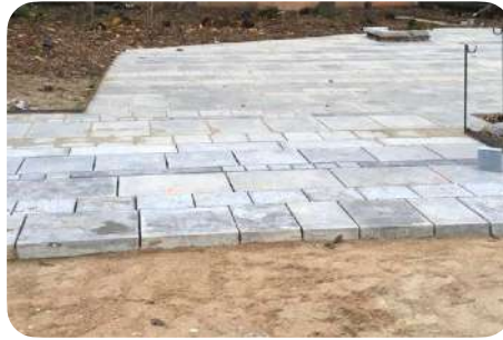
Slabs on sand © Perrine Henault, Atelier NOUS
