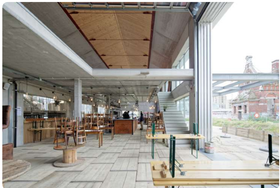
Reuse of "steenschotten" in flooring and terrace floors. Brasserie de la Senne. Brussels (BE). Archi : La Générale © François Lichtlé.
