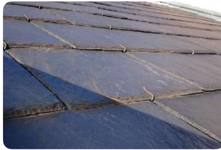
Hook installation, Caserne de Reuilly, Paris (FR)
