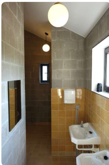
Washbasins reuse. Chiro Itterbeek (BE) © Rotor
