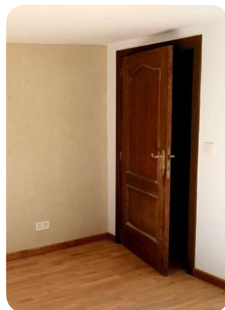
Reuse of panelled wooden door © Sophie Boone (BE)
