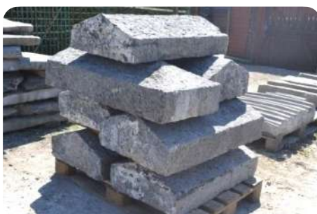
Reclaimed blue stone (limestone) coping stones © Het arduinen hoekje
