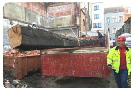
Dismantling of the timber beams of the "Tour à Plomb", Brussels (BE). © BVDA - Bernard Van Damme Architecte
