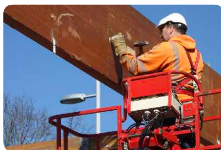
Vorbereiding voor demontage
