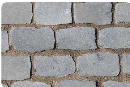
Aanbrengen van gezaagde straatstenen
