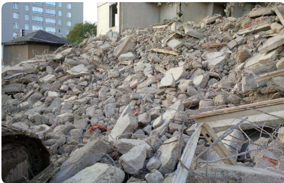
Brokstukken betonpuin bij de afbraak van een toren in Clos Saint Lazare in Stains (FR).
