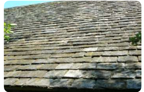
Genagelde plaatsing van hergebruikleien, dik model met variërende leihogte en breedte (FR) © Sarl Ritouet
