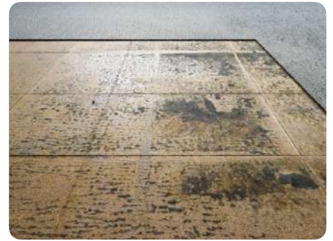
Lijmresten op de bovenzijde van de tegels.
