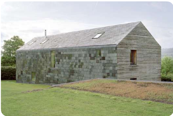
Dak en gevelbekleding in hergebruikleien, Ty Pren project (VK), Feilden Fowles architecten © David Grandorge
