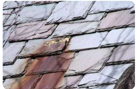
Minerale insluitsels en roestsporen © nachi.org
