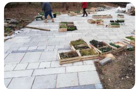
Hergebruiktegels uit graniet en Henegouwse steen in verschillende afmetingen en vormen, afkomstig uit de opslagplaats van de stad Parijs. Square de la biodiversité, Parijs (FR) © Perrine Henault, Atelier NOUS
