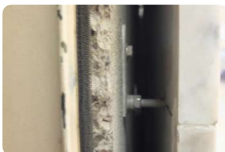
Mechanisch bevestigde natuursteenbekleding
