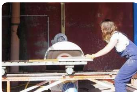
Verwijderen van voegmortelresten op de randen met een slijpmachine
