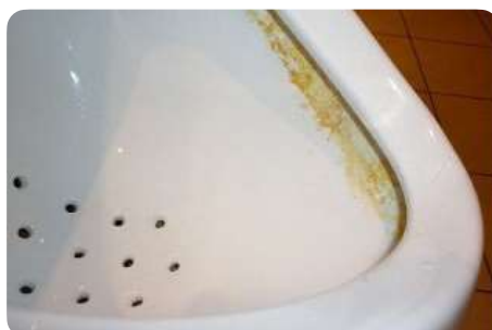
Sporen van kalkaanslag ter hoogte van de spoelrand vóór reiniging
