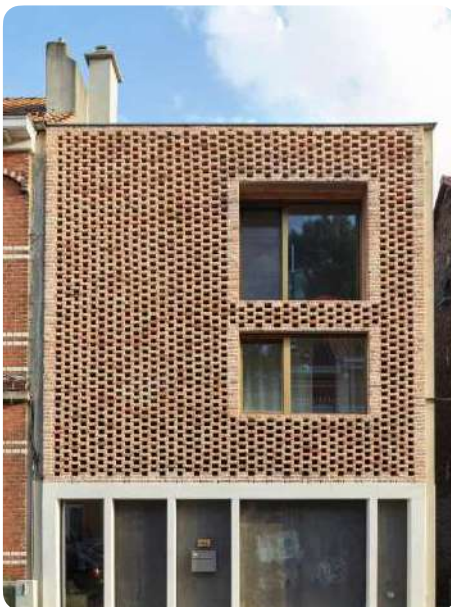
Buitengevel in recuperatiebaksteen. Maison Vignette (BE) © Giulia Frigerio. Architect: Karbon' architecture & Urbanisme
