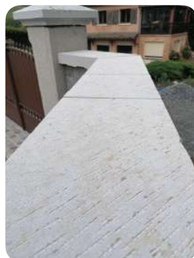
Inspiratie . Platte muurkappen gezaagd uit gerecupereerde blokken Villebois-steen © Antic-Mat
