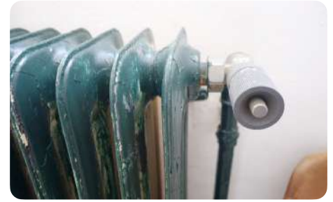
Sommige modellen plaatstalen radiatoren kunnen verward worden met gietijzeren radiatoren.
