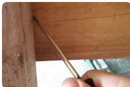
Test met een schroevendraaier © qualite.bzh
