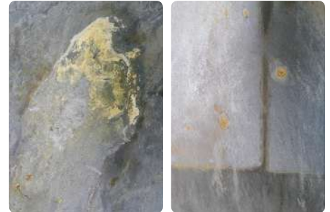
Minerale insluitsels en roestsporen
