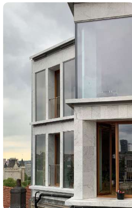
Hergebruik van de platen als gevelbekleding, Project Jaspar, Architect Guillaume Sokal, Brussel (BE). © Guillaume Sokal
