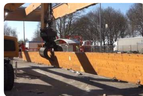
Demontage van balken van GGH
