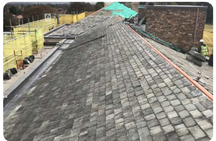
Plaatsing van hergebruikleien op een dak © thereclaimedcompany.co.uk
