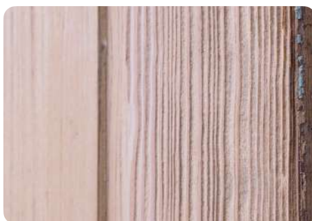
Zandstralen van houten elementen maakt de houtnerven dieper
