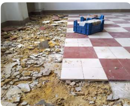
Demontage van de tegels
