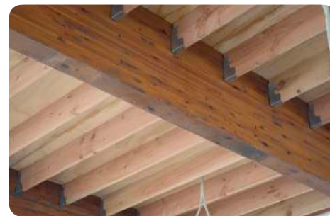
Gelamelleerde houten balken geïntegreerd in een nieuw project
