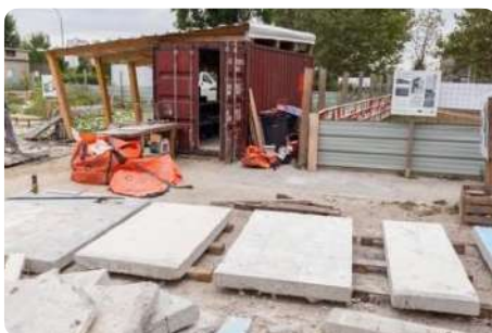
Het paviljoen van de Fabrique du Clos in Stains. Bij de afbraak van een wooncomplex in Stains werd een deel van de betonnen elementen hergebruikt op het terrein. De losgemaakte betonnen muren werden ter plaatse verzaagd en hergebruikt als niet-dragende muren voor een fietsstalling (en de aanleg van de buitenruimte werd eveneens uitgevoerd met gerecupereerde betonplaten). Opdrachtgever: Seine-Saint-Denis Habitat. Ontwerp: Bellastock. Stains (France), 2017 © Alexis Leclercq
