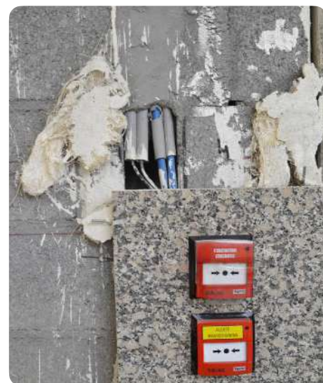
Demontage van platen in graniet voor binnenmuurbekleding
