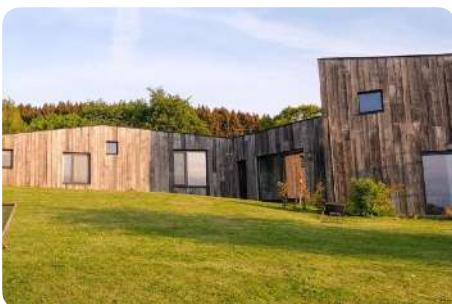
Gevelbekleding in barnwood voor een woning en gastenkamers (Cerftitude) © Benoit Lanis. Architect: Atelier 4/5. https://opalix.eu/nl/projecten/cerftitude
