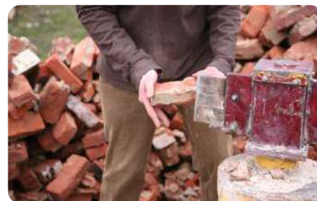
Mechanische reiniging van mortelresten
