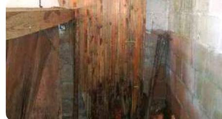
Aantasting door langdurige blootstelling aan vocht © SGI
