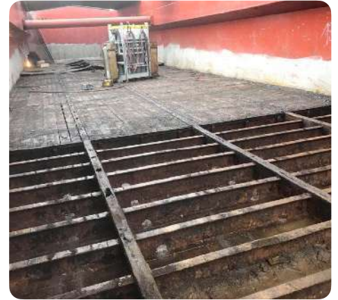
Ontmanteling van het ruim van een binnenschip © historischhout.nl
