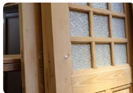
Gedecapeerde en opgeschuurde paneeldeur
