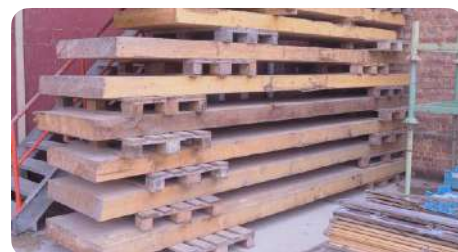
Opslag van gerecupereerde balken van GGH
