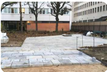
Hergebruiktegels uit graniet en Henegouwse steen in verschillende afmetingen en vormen, afkomstig uit de opslagplaats van de stad Parijs. Square de la biodiversité, Parijs (FR) © Perrine Henault, Atelier NOUS
