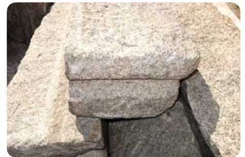
Boordstenen met tand-en-groefstelsel (graniet)
