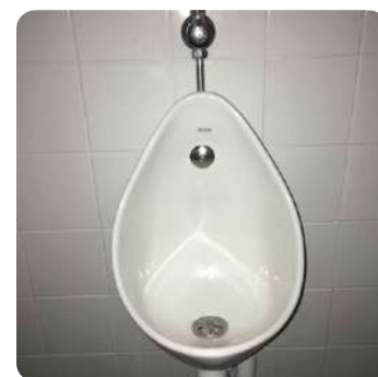
Hangurinoir met dynamische spoeling, metalen sproeikop en afvoerplug, en zichtbare watertoe- en afvoer. © backacia.com
