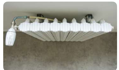
Caserne de Reuilly, Paris Habitat (FR) - Hergebruik in situ van 85 gietijzeren radiatoren. © Rotor en Sixième Continent
