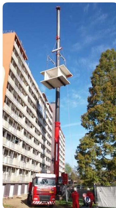
Project Super Local. Binnen dit in 2017 in Nederland uitgevoerde experimentele project werd een procédé ontwikkeld om driedimensionale betonnen modules die uit een oud woongebouw werden gerecupereerd, te gebruiken voor de bouw van nieuwe woningen. De modules bestaan uit vloer- en plafondplaten en muren, die werden verzaagd alvorens met een kraan te worden opgehesen en per vrachtwagen naar de nabijgelegen werf te worden vervoerd. Opdrachtgever: HEEMWonen. Architect: SeC Architecten. Aannemer: Jongen Construction. Onderzoekseenheid: Zuyd University of Applied Sciences, Research group SURD.
