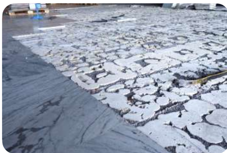
Tegels in een mortelbed
