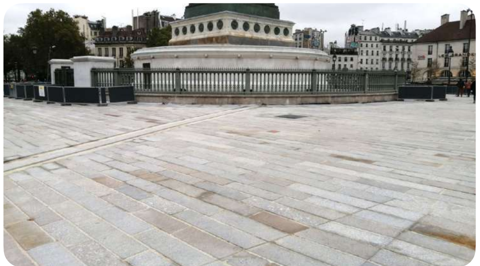
Place de la Bastille, Parijs (FR). Hergebruik van 10 000 oude stoepranden die overlangs verzaagd werden om te dienen als pleintegels. © Benjamin Randow
