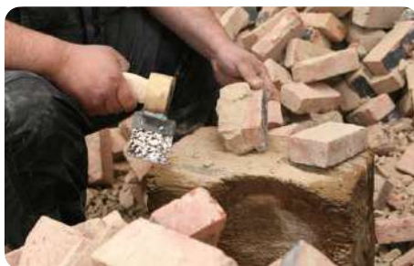
Manuele reiniging van mortelresten
