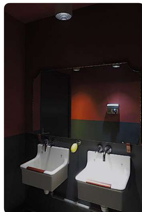
Hergebruik van uitgietsbakken, Bar Mono Le Terrain Vague, Paris (FR) © FAIRE AVEC architecture
