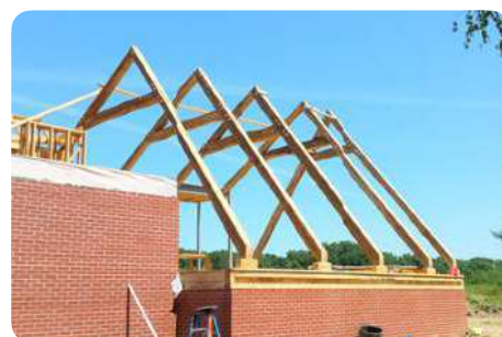
Hergebruik van houten balken voor een nieuw dakgebinte © yr-architecture (USA)
