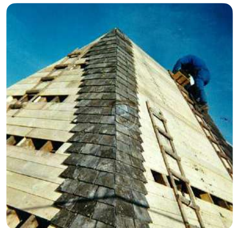
Gehaakte plaatsing van hergebruikleien, dik model met variërende leihogte en breedte (FR) © Sarl Ritouet
