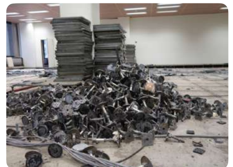
Niet herbruikbare vijzels door aanzienlijke lijmresten.
