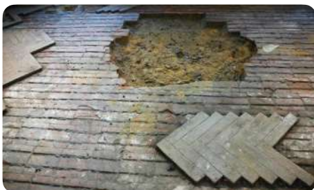
Hergebruik van 50 m 2 parket in visgraatmotief. De planken werden in de dikte doorgezaagd om de oude bitumenlijm te verwijderen. Daarna werden ze bewerkt om in Hongaarse punt te worden geplaatst (gelijmde plaatsing), Boom, België © Atelier Passe Partout
