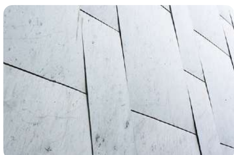
Kromtrekken van natuurstenen platen. Alvar Aalto's Finlandia Hall, Helsinki © University Of Helsinki
