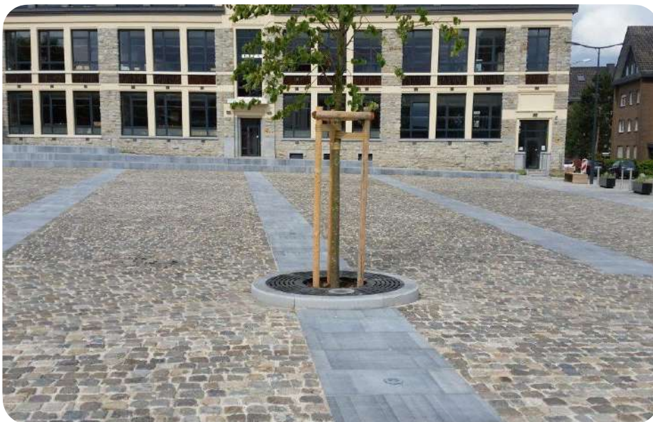
Hergebruikkasseien. Gemeenteplein van Raeren (BE) © Carrière de la Hazotte
