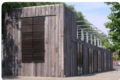
Hergebruik van 800 m 2 barnwood als houten gevelbekleding en lambrisering. Quay01 (K-nal), Brussel, België © Jean-Paul Hermant Architectes https://opalix.eu/nl/projecten/gevelbekleding-quay01-k-nal
