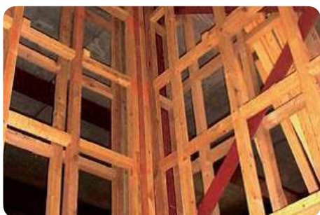
Gebruik van 350 m 3 gerecupereerd hout om de structuur voor gipsplaatwanden te maken, BedZED. © Bill Dunster Architects (ZEDfactory, 2002) (UK)
