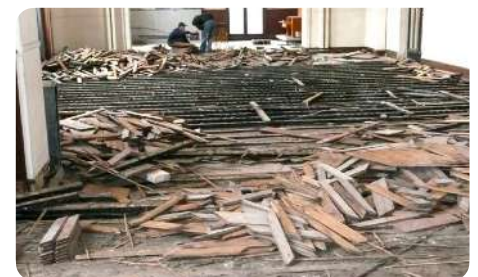
Demontage van een op lambourdes vernagelde parketvloer
