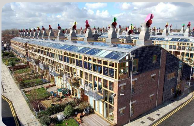
Bedzed-project (2002), Hackbridge (VK). Hergebruik van 95 ton staal © Bill Dunster Architects, ZedFactory
