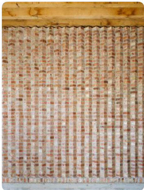
Binnengevel in recuperatiebaksteen. Zonnige Kempen (BE).
