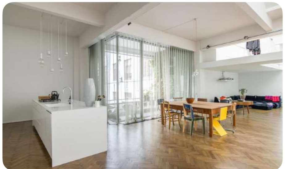
Hergebruik van 290 m 2 parket in eik, visgraatmotief, privéproject, Brussel, België © K2A architecten, Oana Crainic.
