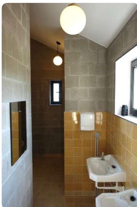
Hergebruik van wastafels, Chiro Itterbeek (BE) © Rotor
