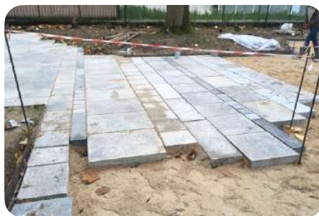
Hergebruiktegels uit graniet en Henegouwse steen in verschillende afmetingen en vormen, afkomstig uit de opslagplaats van de stad Parijs. Square de la biodiversité, Parijs (FR) © Perrine Henault, Atelier NOUS
