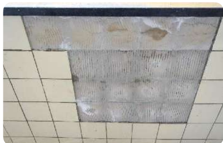
Demontage van de tegels
