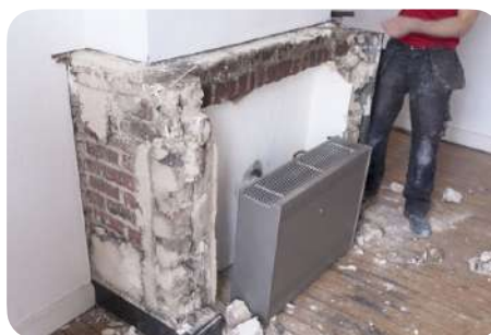
Demontage van een schoorsteenmantel
