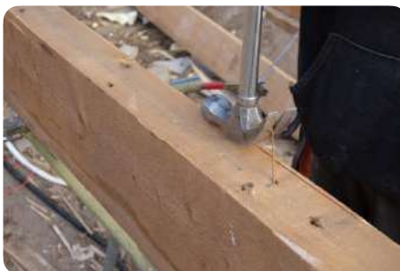
Verwijderen van metalen elementen
