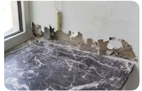
Vrijmaken van de uiteinden van het tablet
