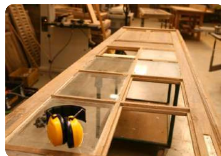
Vervangen van beglazingselementen
