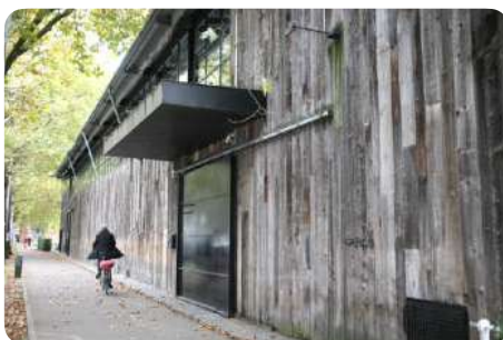
Hergebruik van 800 m 2 barnwood als houten gevelbekleding en lambrisering. Quay01 (K-nal), Brussel, België © Jean-Paul Hermant Architectes https://opalix.eu/nl/projecten/gevelbekleding-quay01-k-nal
