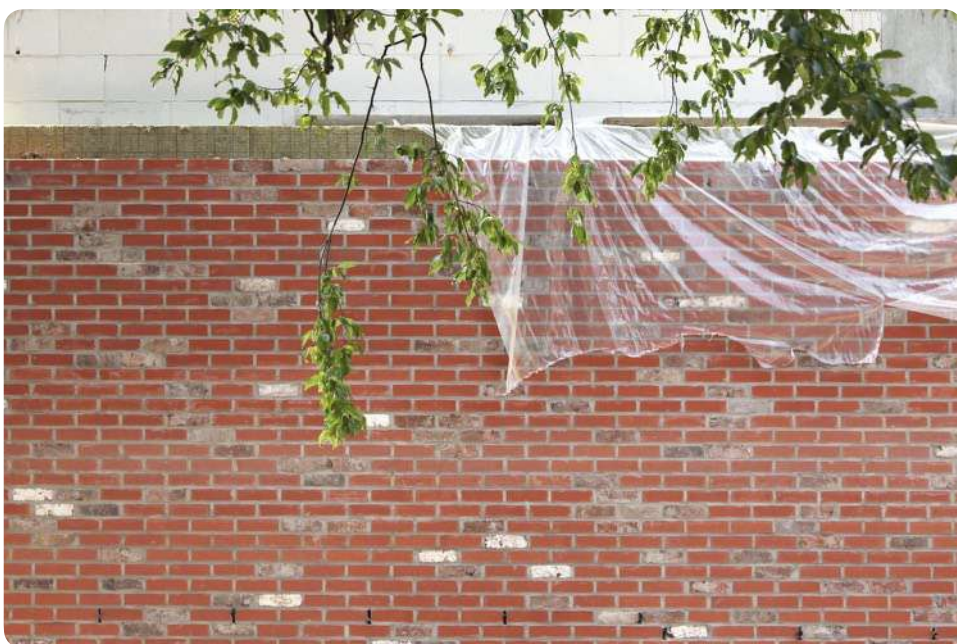
Mix van recuperatiebakstenen en nieuwe bakstenen. Folkloremuseum, Moeskroen, (BE). © V+ architectes
