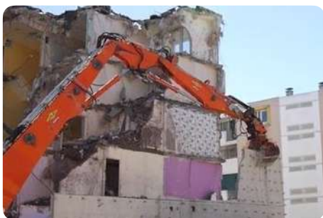
Het paviljoen van de Fabrique du Clos in Stains. Bij de afbraak van een wooncomplex in Stains werd een deel van de betonnen elementen hergebruikt op het terrein. De losgemaakte betonnen muren werden ter plaatse verzaagd en hergebruikt als niet-dragende muren voor een fietsstalling (en de aanleg van de buitenruimte werd eveneens uitgevoerd met gerecupereerde betonplaten). Opdrachtgever: Seine-Saint-Denis Habitat. Ontwerp: Bellastock. Stains (France), 2017 © Alexis Leclercq
