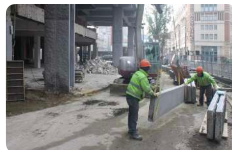
Demontage van natuurstenen elementen
