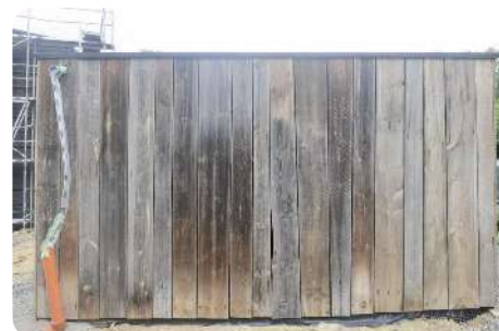
Hergebruik van 800 m 2 barnwood als houten gevelbekleding en lambrisering. Quay01 (K-nal), Brussel, België © Jean-Paul Hermant Architectes https://opalix.eu/nl/projecten/gevelbekleding-quay01-k-nal
