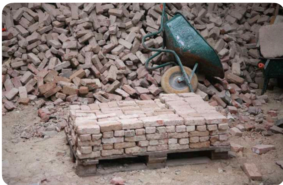
Reinigen en sorteren van gerecupereerde bakstenen
