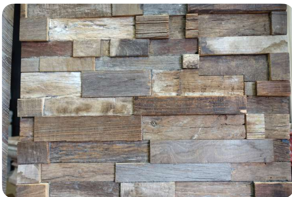
Lambrisering gemaakt van planken in verschillende houtsoorten en afmetingen.
