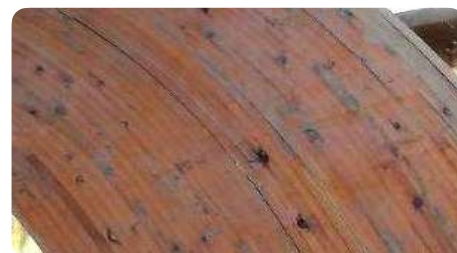
Scheurtjes door delaminatie © SGI
