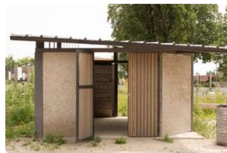
Het paviljoen van de Fabrique du Clos in Stains. Bij de afbraak van een wooncomplex in Stains werd een deel van de betonnen elementen hergebruikt op het terrein. De losgemaakte betonnen muren werden ter plaatse verzaagd en hergebruikt als niet-dragende muren voor een fietsstalling (en de aanleg van de buitenruimte werd eveneens uitgevoerd met gerecupereerde betonplaten). Opdrachtgever: Seine-Saint-Denis Habitat. Ontwerp: Bellastock. Stains (France), 2017 © Alexis Leclercq
