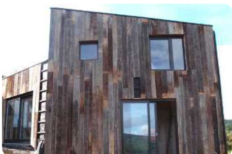
Gevelbekleding in barnwood voor een woning en gastenkamers (Cerftitude) © Benoit Lanis. Architect: Atelier 4/5. https://opalix.eu/nl/projecten/cerftitude
