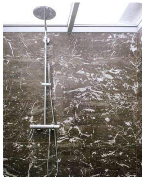
Doucheruimte uitgevoerd in hergebruikt rood marmer. Brussels (BE) © Séverin Malaud
