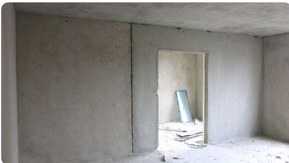
Geprefabriceerde binnenwanden, na verwijdering van muurbekleding en asbestwerkzaamheden, voor afbraak of ontmanteling van het gebouw.
