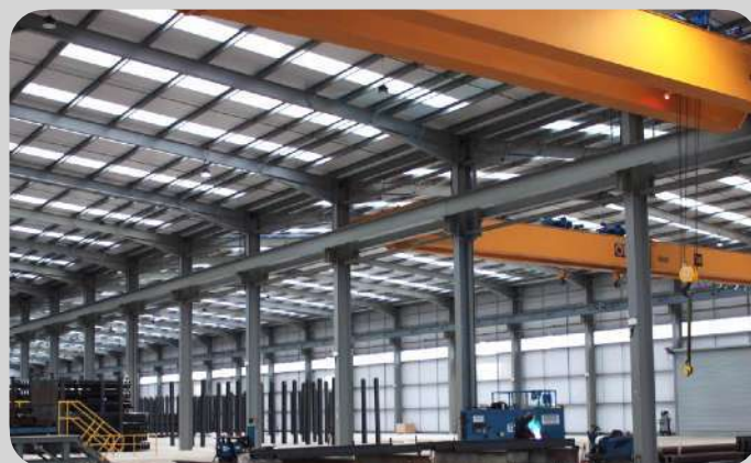
NTS-gebouw (2017), Thirsk (VK). Hergebruik van stalen liggers als draagstructuur © Cleveland Steel and Tubes (CST)
