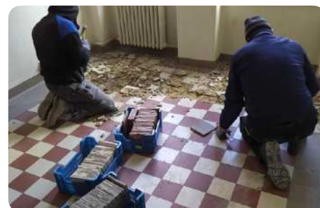
Demontage van keramische tegels
