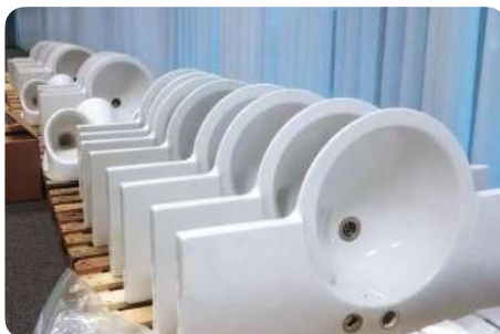
Demontage van wastafels voor hergebruik
