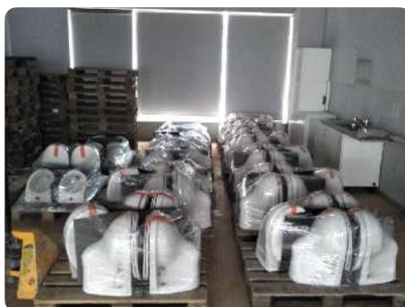
Demontage van wc-potten voor hergebruik
