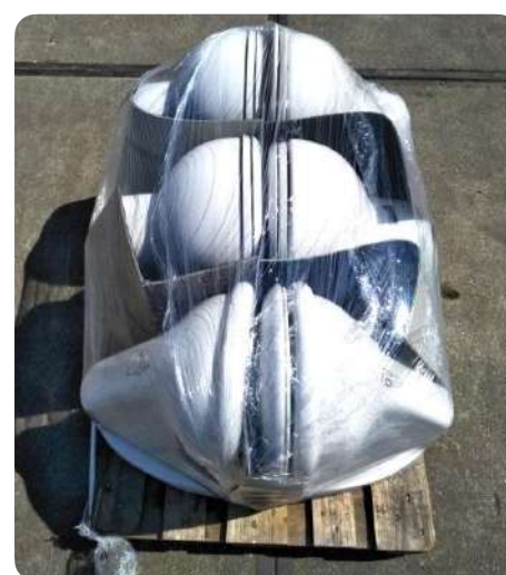
Demontage van wc-potten voor hergebruik
