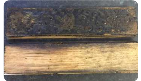
Verwijderen van bitumineuze lijmresten © www.parquetbitumenremoval.co.uk
