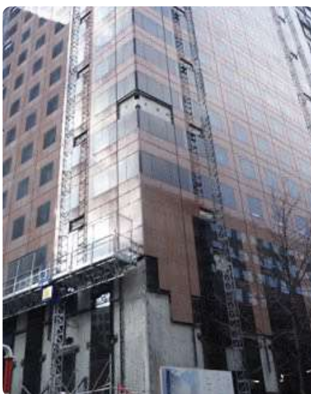
Recuperatie van 5.300 m 2 natuursteenplaten van rood graniet afkomstig van de gevels van de Tour Cèdre in La Défense, Parijs (FR). © Incomex http://pierre-reemploi.com/offre/granit-rouge-de-facade-nr01/
