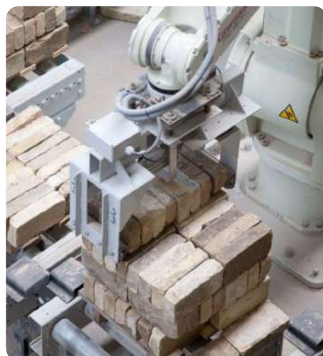
Sortering en gemechaniseerde verpakking van gerecupereerde bakstenen © Gamle Mursten (DK)
