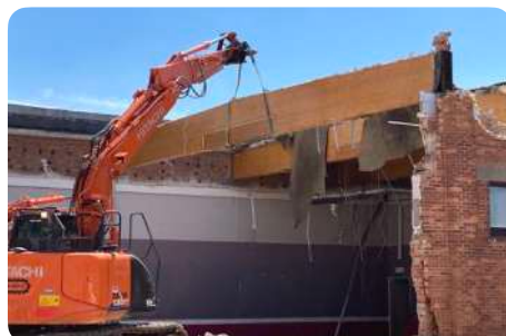
Demontage van balken van GGH
