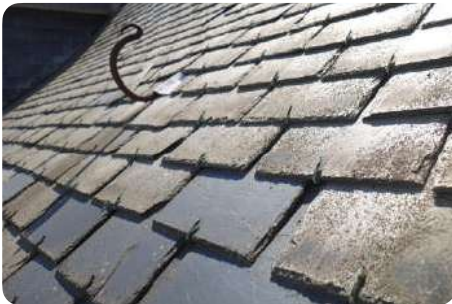
'Originele' en 'reparatieleien'
