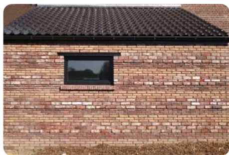
Gevelverband met drie verschillende modellen hergebruikbakstenen. Chiro Itterbeek (BE). © ROTOR
