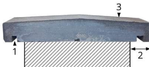
Figuur 1. Profiel van een natuurstenen muurdeksel
