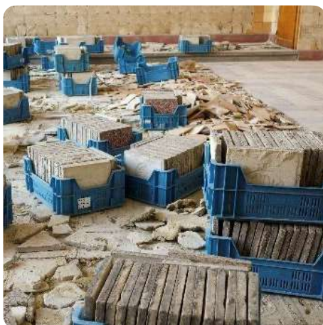
Demontage van de tegels
