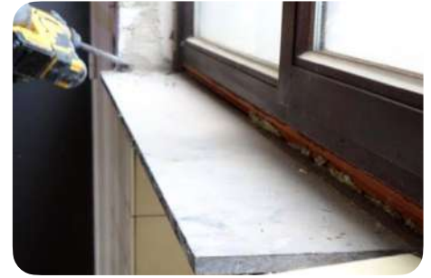
Vrijmaken van de uiteinden van het tablet
