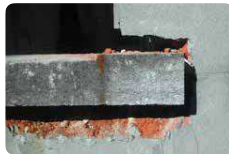
Vrijmaken van de boven-, zij- en onderkant van de dorpel © CDR Construction
