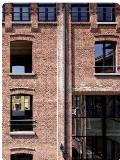
Hergebruik van dorpels van blauwe hardsteen, in situ gerecupereerd © François Lichtlé, L'Escaut Architectures. https://opalis.eu/nl/projecten/verbouwing-van-de-oude-belle-vue-brouwerijen
