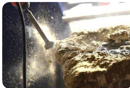
Verwijderen van mortelresten met behulp van een pneumatische beitel © De Opkamer
