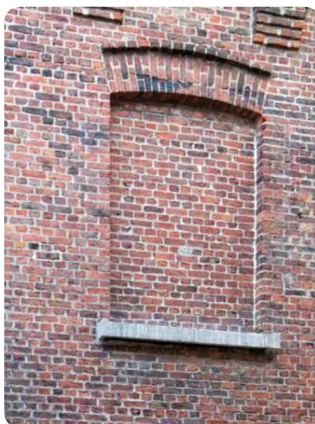
Hergebruik van dorpels van blauwe hardsteen, in situ gerecupereerd © François Lichtlé, L'Escaut Architectures. https://opalis.eu/nl/projecten/verbouwing-van-de-oude-belle-vue-brouwerijen
