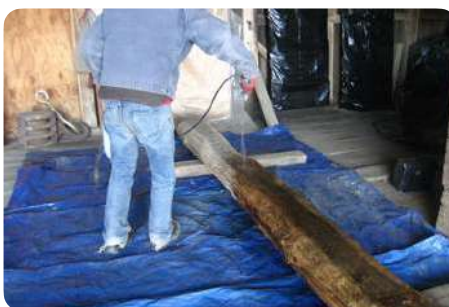
Afwerkingsbehandeling van het hout © yr-architecture
