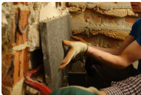
Bekleding in natuursteen bevestigd met metalen ankers, vastgezet in morteldotten.
