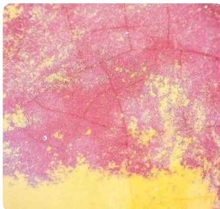
Close-up van craquelé op een cementtegel
