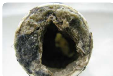
Deels gereinigd afvoerelement
