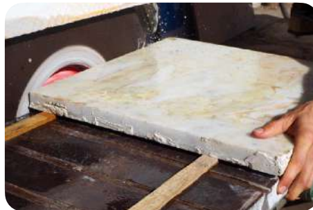
Verwijderen van mortelresten op de rand met behulp van een slijpmachine
