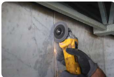
Doorslijpen van de bevestigingsmiddelen
