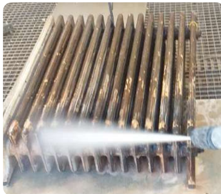
Nettoyage à haute pression
