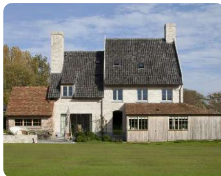
Exemple de tuiles de toit en terre cuite réemployées (BE) © recupan.be
