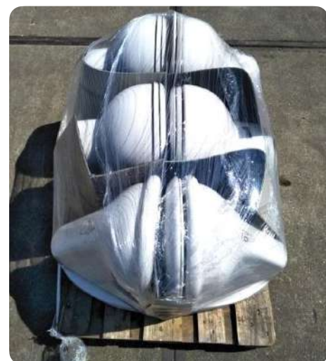
Dépose de cuvettes de WC en vue de leur réemploi
