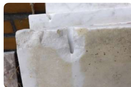
Trou d'ergot élargi lors de la dépose
