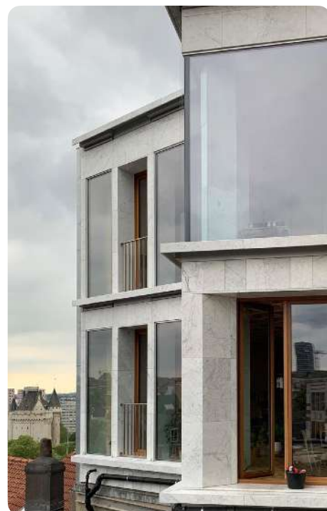
Remise en œuvre des dalles en parement extérieur, Projet Jaspas, Architecte Guillaume Sokal, Bruxelles (BE). © Guillaume Sokal
