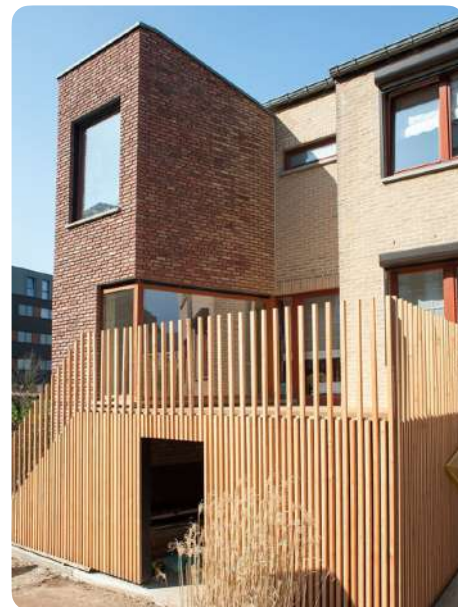
Extension d'une maison unifamiliale. Parement de façade en brique de réemploi. Bruxelles (BE) © Sophie Boone pour VLA-Architecture
