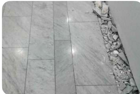
« Cassage » d'une première ligne de dalles
