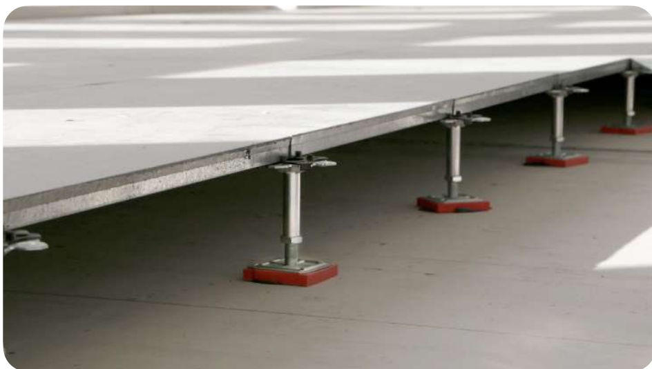
Remise en œuvre de dalles de plancher surélevé de réemploi avec vérins neufs (FR). © Mobius - Marie Moroté
