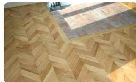
Réemploi de 50 m 2 de parquet à bâton rompu. Les lames ont été sciées dans l'épaisseur afin d'éliminer l'ancienne colle au bitume. Elles ont ensuite été réusinées afin d'être remise en œuvre (pose collée) sous un motif en point de Hongrie, Boom (BE) © Atelier Passe Partout
