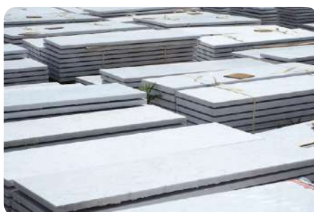
Stockage des dalles nettoyées
