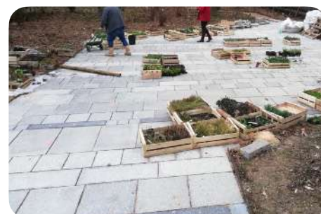
Réemploi de dalles en granite et pierre du Hainaut de dimensions et formes variées, récupérées au dépôt de la ville de Paris. Square de la biodiversité, Paris (FR) © Perrine Henault, Atelier NOUS
