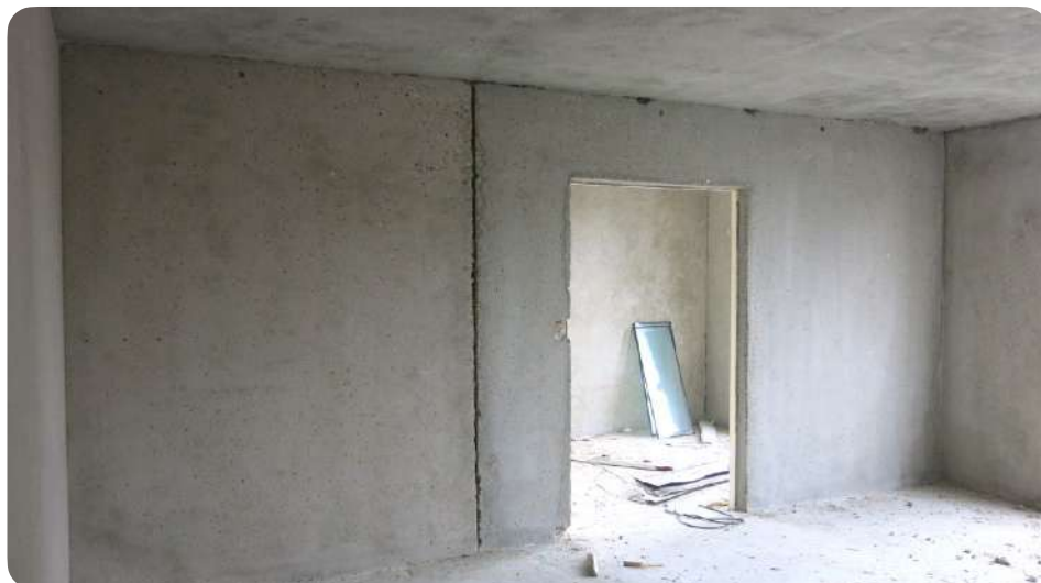
Voiles préfabriquées après décapage des revêtements intérieurs et désamiantage des surfaces, avant démolition ou déconstruction du bâtiment.
