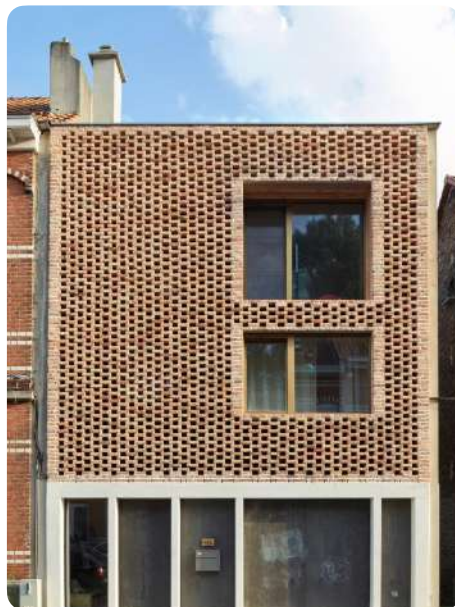
Parement de façade en brique de réemploi. Maison Vignette (BE) © Giulia Frigerio. Architecte : Karbon' architecture & Urbanisme
