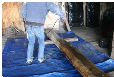
Traitement de finition du bois © yr-architecture
