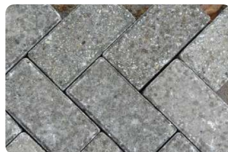
Pavés en béton de réemploi
