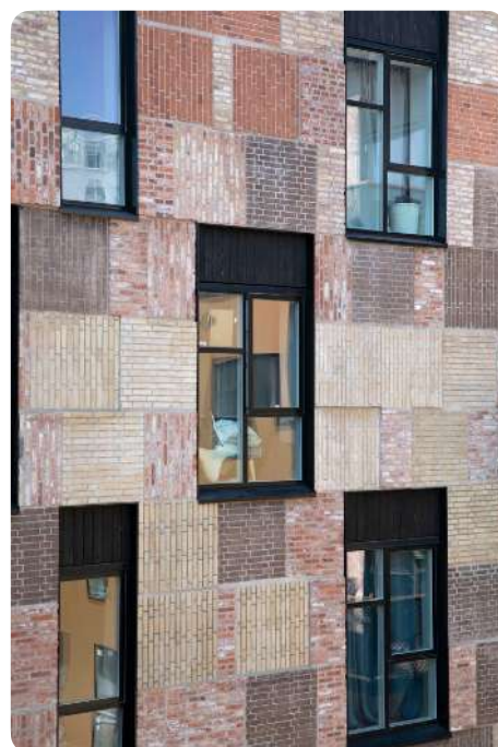
Réemploi de modules de briques. The Resource Rows. © Lendager Group (DK)
