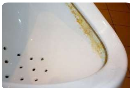
Traces de tartre au niveau de la bride, avant nettoyage
