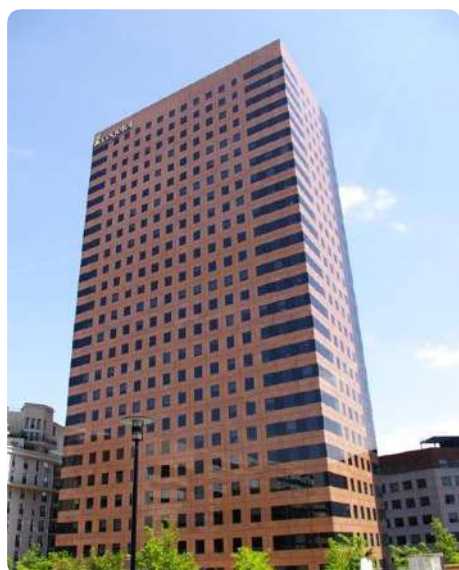
Récupération de 5300 m 2 de dalles en granit rouge provenant des façades de la Tour Cèdre à La Défense, Paris (FR). © Incomex http://pierre-reemploi.com/offre/granit-rouge-de-facade-nr01/
