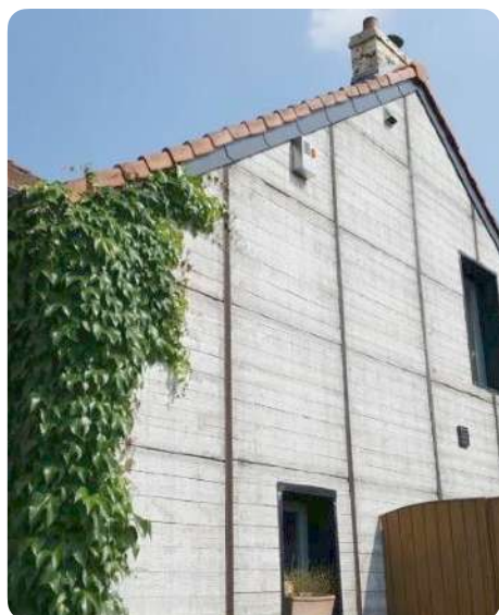
Exemples de réutilisation de steenschotten © panneauxleontine.be
