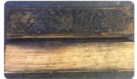
Nettoyage des reste de colle bitumineuse © www.parquetbitumenremoval.co.uk
