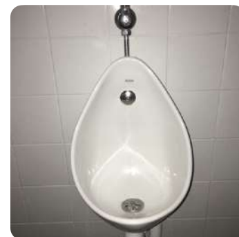
Urinoir suspendu à effet d'eau, diffuseur et bonde métallique, alimentation et évacuation apparente. © backacia.com
