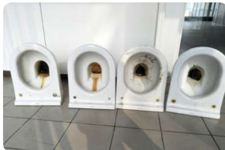
Cuvettes suspendues encrassées
