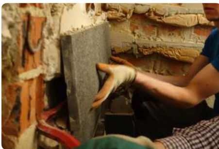
Revêtement en pierre fixée à l'aide d'agrafes métalliques scellées dans des plots au mortier
