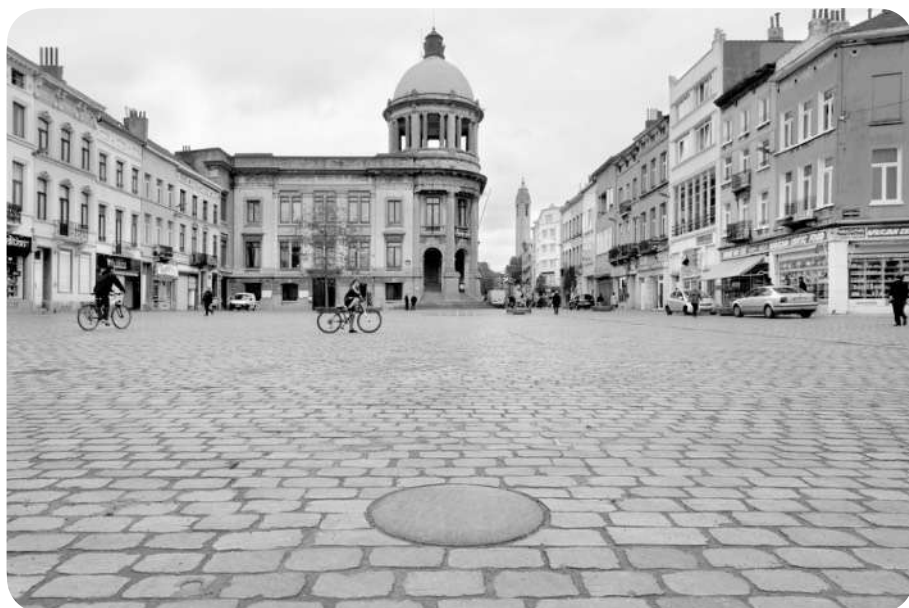
Pavés de réemploi sciés, Place communale de Molenbeek (BE). © a practice, Atelier Ruimtelijk advies et Marie-Françoise Plissart
