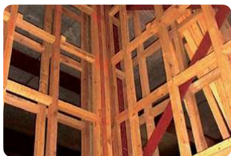
Cloisons en ossature bois de réemploi : 350 m³ de bois récupérés pour créer la structure des cloisons en plaque de plâtre, BedZED . © Bill Dunster Architects (ZEDfactory, 2002) (UK)
