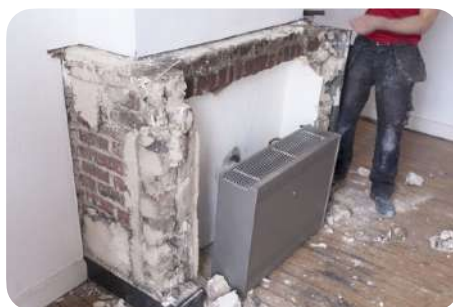
Dépose de la tablette et du manteau de la cheminée
