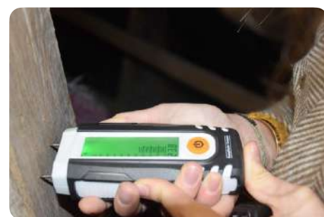
Mesure d'humidité du bois à l'aide d'un humidimètre © Romane Lavoine
