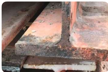
Dégradation du revêtement d'origine © Gebruikte bouwmaterialen Weert
