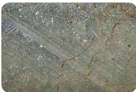
Fissures superficielles
