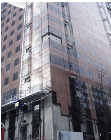
Récupération de 5300 m 2 de dalles en granit rouge provenant des façades de la Tour Cèdre à La Défense, Paris (FR). © Incomex http://pierre-reemploi.com/offre/granit-rouge-de-facade-nr01/
