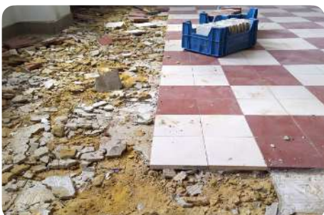
Démontage de carreaux
