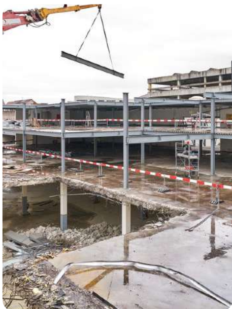
Récupération des poutrelles
