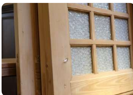
Porte à panneau décapée et poncée
