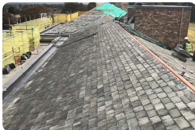
Ardoise de réemploi et remise en oeuvre en toiture, © thereclaimedcompany.co.uk
