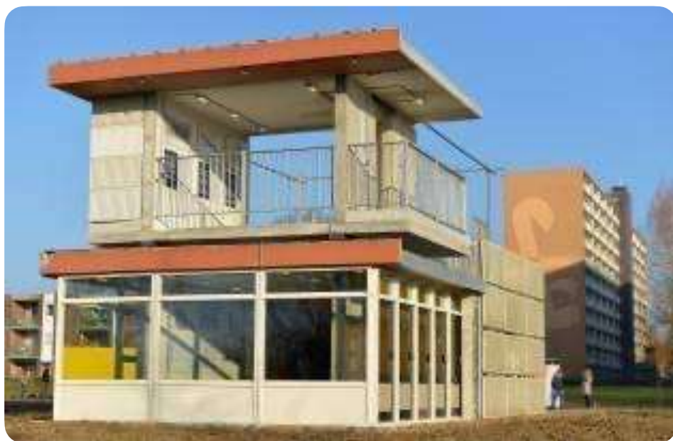
Projet Super Local. Ce projet expérimental réalisé en 2017 aux Pays-Bas a mis en place un procédé de réemploi de modules tridimensionnels de béton extraits d'un ancien bâtiment de logements, pour la construction de maisons individuelles. Les modules sont composés de dalles et de murs, ils ont été sciés avant d'être extraits à la grue et transportés par camion sur le chantier de réemploi à proximité. Client : HEEMWonen. Architecte : SeC Architects. Entreprise : Jongen Construction. Unité de recherche : Zuyd University of Applied Sciences, Research group SURD.
