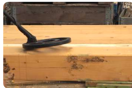
Inspection au détecteur de métaux
