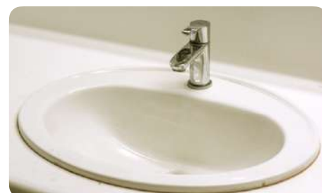
Lavabo posé ou encastré : dans un meuble ou sur un plan de toilette (encastrement par le dessus ou par le dessous)
