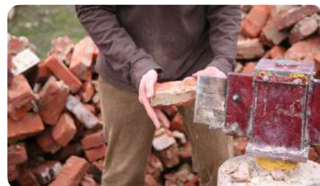
Nettoyage mécanique des reste de mortier
