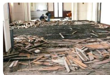
Dépose d'un parquet cloué sur lambourdes
