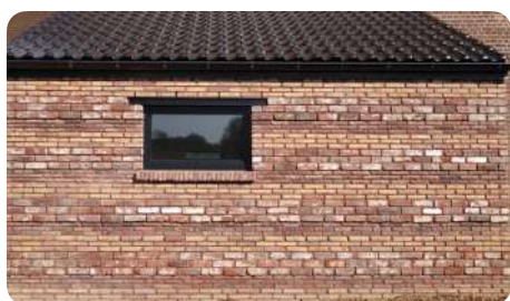
Appareillage d'une façade avec trois modèles différents de briques de réemploi. Chiro Itterbeek (BE) © ROTOR
