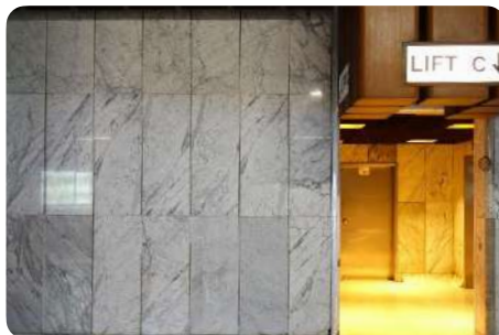
Revêtement mural en dalles de marbre
