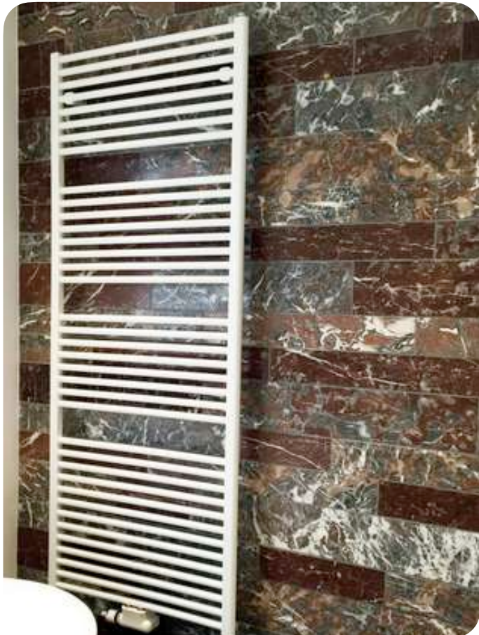
Revêtement mural en tablettes de fenêtrages de réemploi (BE). © Manu Gryson architecte
