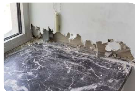
Dégagement des extrémités d'une tablette de fenêtre
