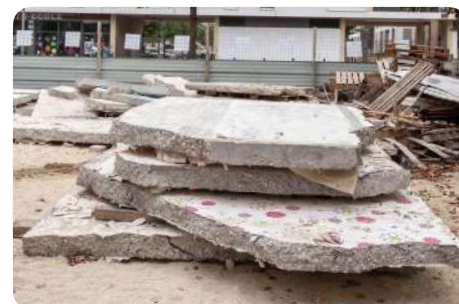
Exemple de voile en béton après une dépose par grignotage © Alexis Leclercq
