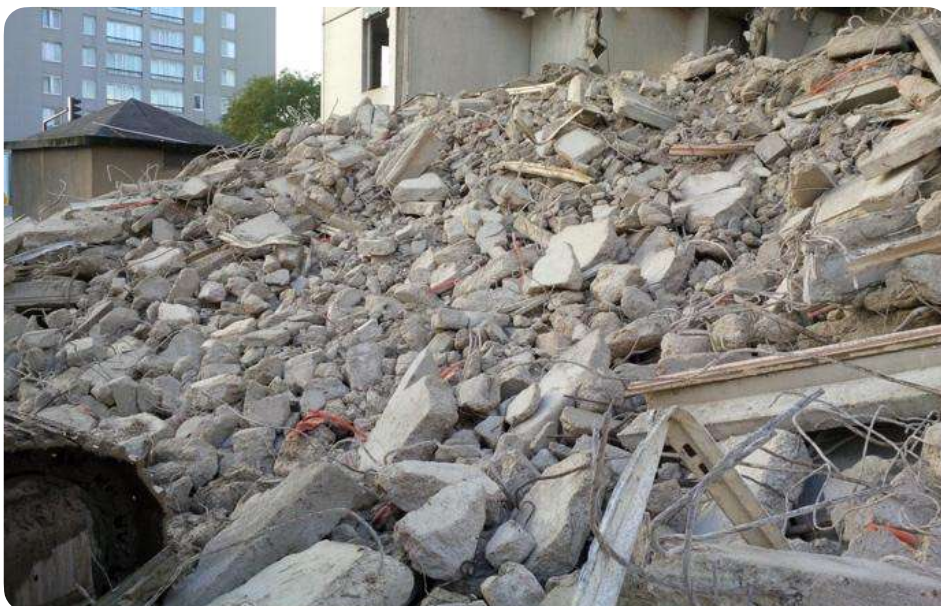
Gravats de béton issus de la démolition d'une tour au Clos Saint Lazare à Stains (FR).
