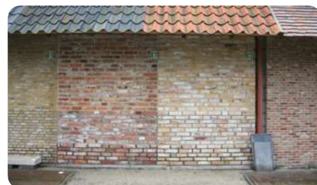
Showroom d'un revendeur de briques de réemploi. Mise en valeur des différents modèles, avec des joints de nature et d'épaisseur variées
