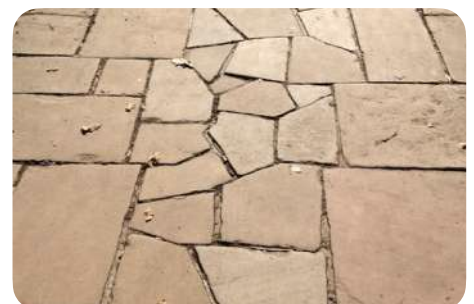
Mélange de dalles carrées en grès de York et de dalles « cassées » posé en Opus Incertum, Holland Park, Londres (UK) © Thornton Kay/Salvo
