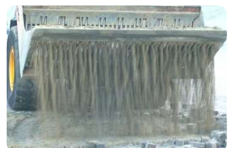
Dépose des pavés au moyen d'un bac à claire-voie (ou dégrilleur) © VSB Sierbestrating
