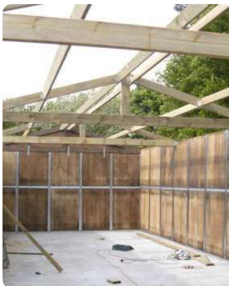
Exemples de réutilisation de steenschotten © panneauxleontine.be
