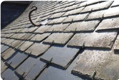
Ardoises d'« origine » et ardoises « de réparation ».
