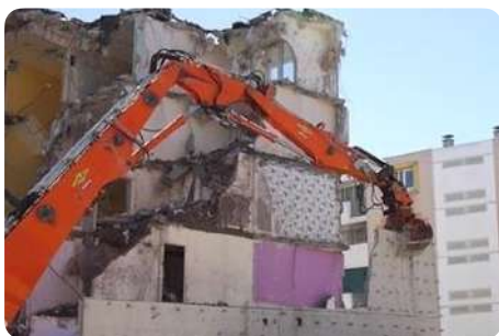
Le pavillon de la Fabrique du Clos à Stains. Lors de la démolition d'un ensemble de logements à Stains, une partie des éléments en béton ont été réemployés sur le site. Les voiles de béton extraits ont été sciés sur place et remis en œuvre comme murs non porteurs d'un local à vélos. Le pavage des sols des espaces extérieurs a également été réalisé à partir de blocs de béton brut. Pouvoir adjudicateur : Seine-Saint-Denis Habitat. Conception : Bellastock. Stains (France), 2017 © Alexis Leclercq
