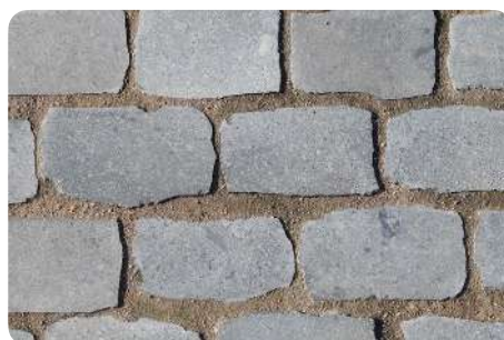
Mise en oeuvre de pavés sciés
