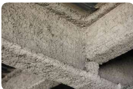
Poutrelles recouverte d'un flocage
