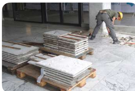
Tri des dalles
