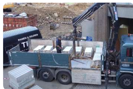
Chargement et transport des dalles
