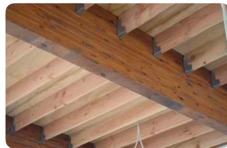
Poutres en bois lamellé collé de réemploi intégrées dans un projet neuf
