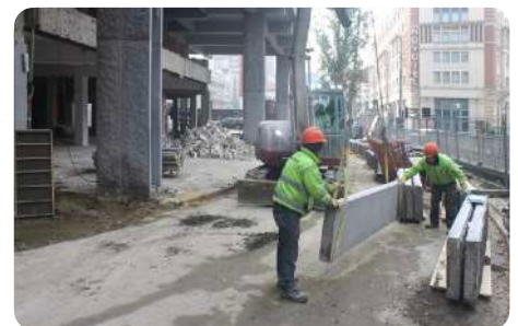
Démontage d'éléments en pierre
