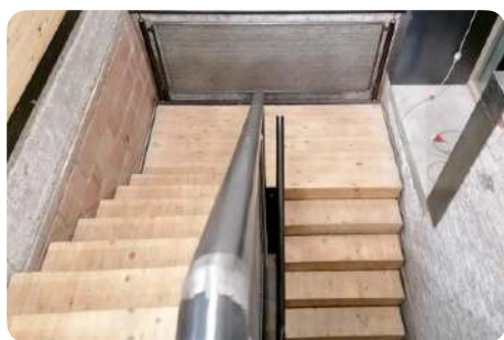
Transformation en marches d'escalier (BE) © Zinneke
