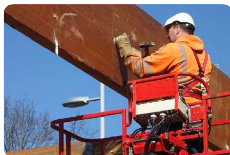
Préparation à la dépose
