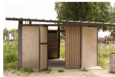
Le pavillon de la Fabrique du Clos à Stains. Lors de la démolition d'un ensemble de logements à Stains, une partie des éléments en béton ont été réemployés sur le site. Les voiles de béton extraits ont été sciés sur place et remis en œuvre comme murs non porteurs d'un local à vélos. Le pavage des sols des espaces extérieurs a également été réalisé à partir de blocs de béton brut. Pouvoir adjudicateur : Seine-Saint-Denis Habitat. Conception : Bellastock. Stains (France), 2017 © Alexis Leclercq
