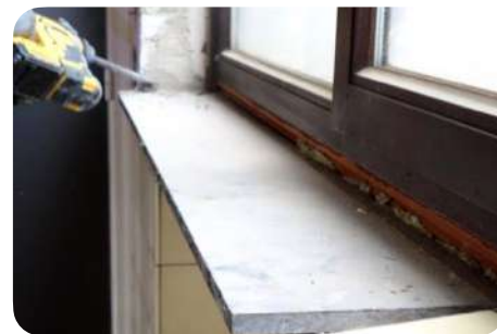
Dégagement des extrémités d'une tablette de fenêtre
