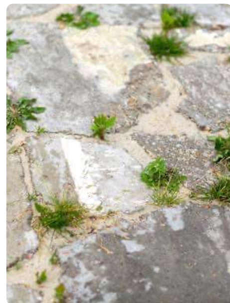
Les « Opus incertum » du Clos Saint Lazare à Stains (FR), 2017. Les bétons issus de la démolition d'un bâtiment de logements construit en 1959 ont fait l'objet d'un réemploi sur site pour revêtir le sol des espaces extérieurs.
