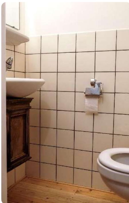
Carreaux de faïence de réemploi dans un espace sanitaire (BE) © VLA ARCHITECTES
