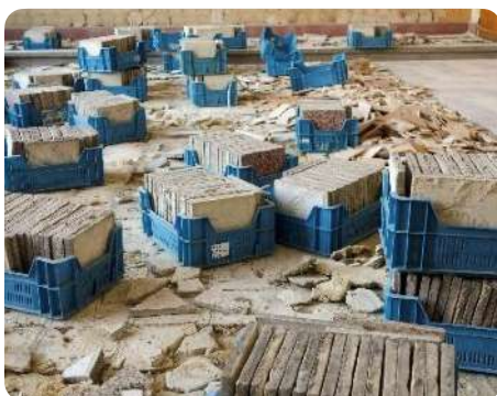
Dépose de carreaux
