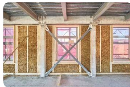
Remise en oeuvre des poutrelles
