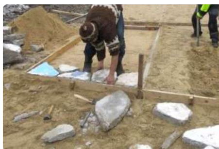
Les « Opus incertum » du Clos Saint Lazare à Stains (FR), 2017. Les bétons issus de la démolition d'un bâtiment de logements construit en 1959 ont fait l'objet d'un réemploi sur site pour revêtir le sol des espaces extérieurs.
