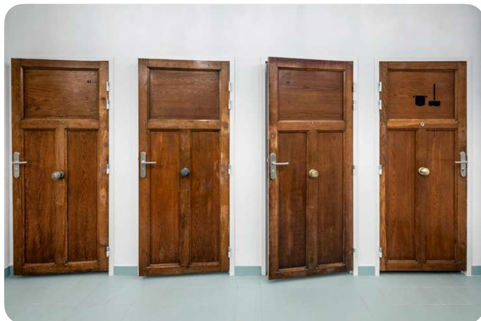
Réemploi de portes à panneaux © Cyrus Cornut, Grande Halle de Colombelles, WIP. Architectes : Encore Heureux (FR)
