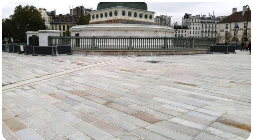
Place de la Bastille, Paris (FR). Réemploi de 10 000 anciennes bordures de trottoir sciées en deux pour être transformées en dalles. © Benjamin Randow
