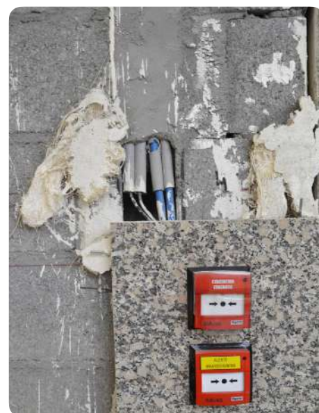
Dépose de dalles de parement intérieur en granite
