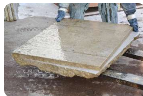
Sciage des dalles dans l'épaisseur, partie supérieure lisse et régulière
