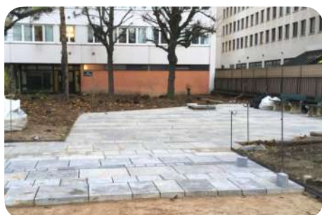
Réemploi de dalles en granite et pierre du Hainaut de dimensions et formes variées, récupérées au dépôt de la ville de Paris. Square de la biodiversité, Paris (FR) © Perrine Henault, Atelier NOUS
