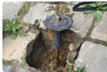
Pavés en grès et pose traditionnelle sur lit de sable : la récupération est généralement aisée
