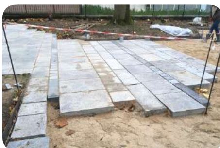
Réemploi de dalles en granite et pierre du Hainaut de dimensions et formes variées, récupérées au dépôt de la ville de Paris. Square de la biodiversité, Paris (FR) © Perrine Henault, Atelier NOUS
