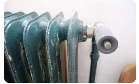
Certains modèles de radiateurs en tôle d'acier peuvent être confondus avec ceux en fonte.
