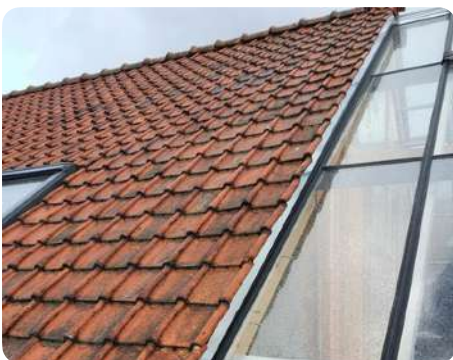
Exemple de tuiles de toit en terre cuite réemployées (BE) © AGWA
