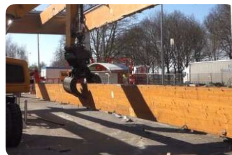
Dépose de poutres en BLC
