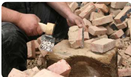
Nettoyage manuel des reste de mortier
