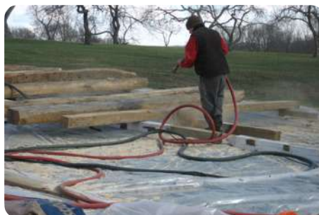
Nettoyage du bois © yr-architecture
