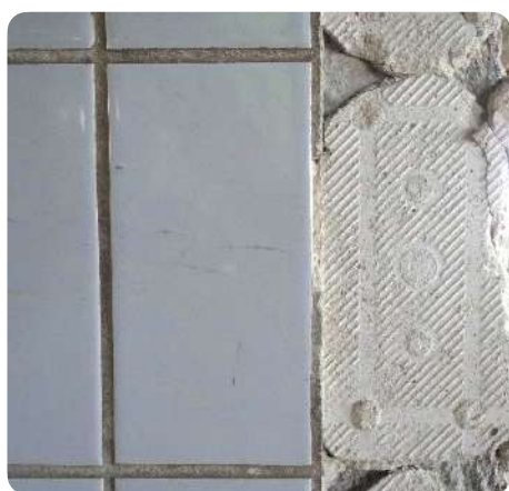
Carreaux de faïence sur mortier bâtard
