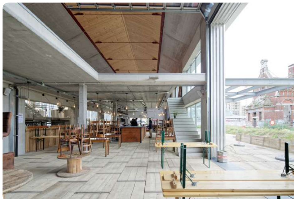
Réemploi de panneaux « steenschotten » en revêtement de sol et en terrasse. Brasserie de la Senne, Bruxelles (BE). Archi : La Générale © François Lichtlé.
