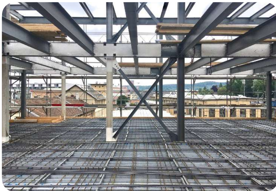
Remise en oeuvre des poutrelles
