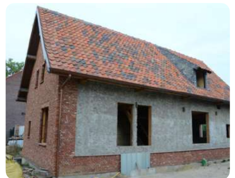
Exemple de tuiles de toit en terre cuite réemployées (BE) © deoudedakpan.be
