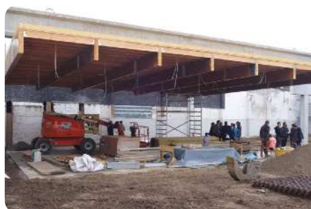
Remise en oeuvre
