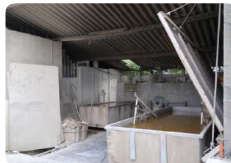
Installation de trempage chimique
