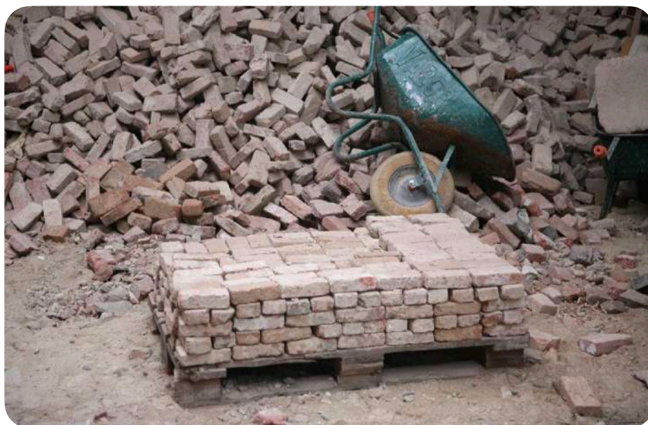
Nettoyage et tri de briques récupérées
