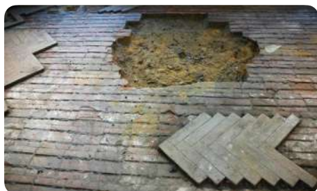
Réemploi de 50 m 2 de parquet à bâton rompu. Les lames ont été sciées dans l'épaisseur afin d'éliminer l'ancienne colle au bitume. Elles ont ensuite été réusinées afin d'être remise en œuvre (pose collée) sous un motif en point de Hongrie, Boom (BE) © Atelier Passe Partout
