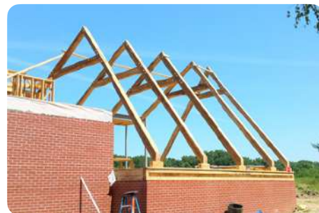
Réemploi de poutres de charpente © yr-architecture (USA)
