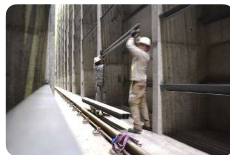
Récupération des poutrelles
