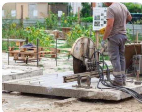
Sciage de voiles béton avant leur réemploi © Alexis Leclercq
