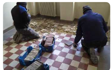
Démontage de carreaux en céramique
