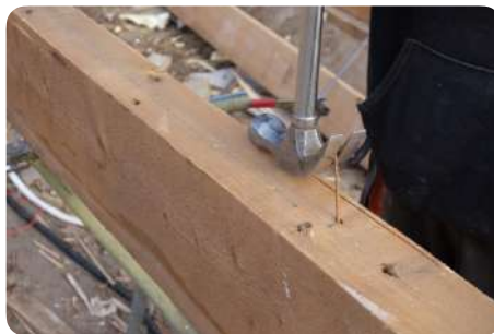
Retrait des éléments métalliques
