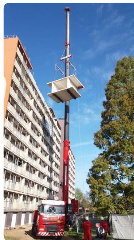
Projet Super Local. Ce projet expérimental réalisé en 2017 aux Pays-Bas a mis en place un procédé de réemploi de modules tridimensionnels de béton extraits d'un ancien bâtiment de logements, pour la construction de maisons individuelles. Les modules sont composés de dalles et de murs, ils ont été sciés avant d'être extraits à la grue et transportés par camion sur le chantier de réemploi à proximité. Client : HEEMWonen. Architecte : SeC Architects. Entreprise : Jongen Construction. Unité de recherche : Zuyd University of Applied Sciences, Research group SURD.
