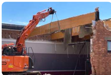
Dépose de poutres en BLC
