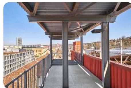
Remise en oeuvre des poutrelles
