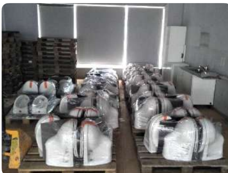
Dépose de cuvettes de WC en vue de leur réemploi
