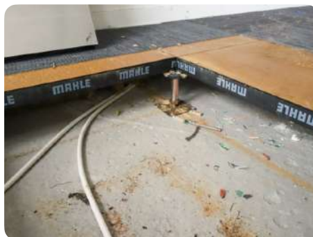
Plancher surélevé autoportant. Dalles à base de bois aggloméré, recouvertes d'un revêtement textile (dalles de moquette).
