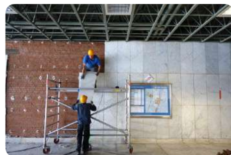
Dépose de dalles en marbre
