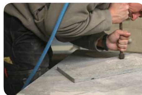
Bouchardage des dalles
