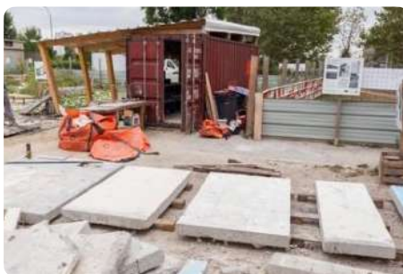
Le pavillon de la Fabrique du Clos à Stains. Lors de la démolition d'un ensemble de logements à Stains, une partie des éléments en béton ont été réemployés sur le site. Les voiles de béton extraits ont été sciés sur place et remis en œuvre comme murs non porteurs d'un local à vélos. Le pavage des sols des espaces extérieurs a également été réalisé à partir de blocs de béton brut. Pouvoir adjudicateur : Seine-Saint-Denis Habitat. Conception : Bellastock. Stains (France), 2017 © Alexis Leclercq
