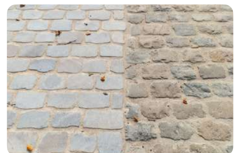
Mise en oeuvre de pavés sciés / bruts
