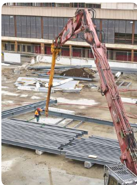
Récupération des poutrelles
