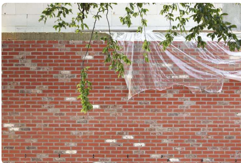
Mélange de briques de réemploi et de briques neuves. Musée du folklore, Mouscron (BE). © V+ architectes
