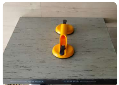
Enlèvement des dalles au moyen d'une ventouse
