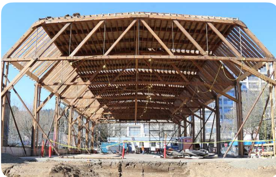
Réemploi de 2000 mètres linéaires d'éléments de structure en bois massif. Redfox Commons (2019) (USA) © LEVER Architecture
