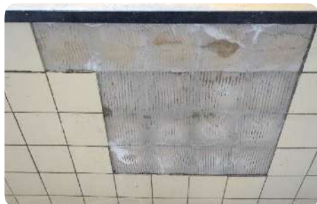
Démontage des carreaux
