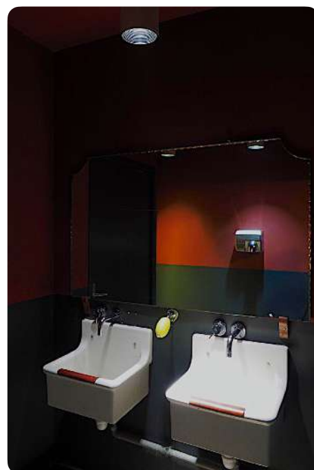
Réemploi de vidoirs, Bar Mono Le Terrain Vague, Paris (FR) © FAIRE AVEC architecture
