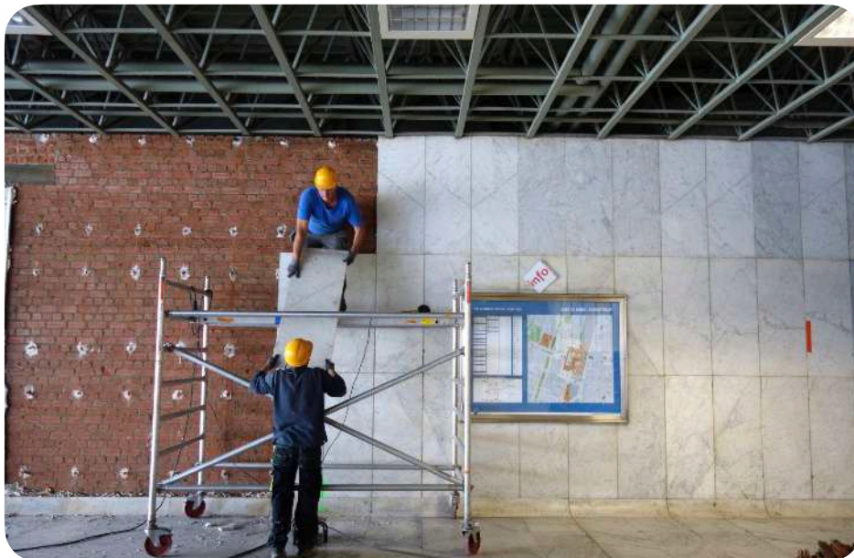
Démontage soigneux de éléments
