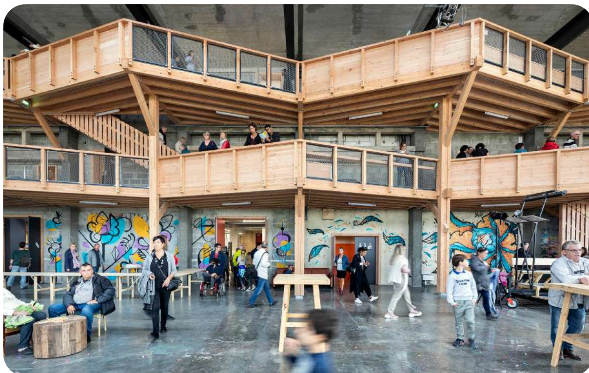
Réemploi de bois de charpente en poteaux de garde corps. © Cyrus Cornut, Grande Halle de Colombelles, WIP. Architectes : Encore Heureux (FR)
