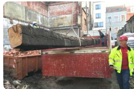
Démontage des poutres en bois de la « Tour à Plomb », Bruxelles (BE). © BVDA - Bernard Van Damme Architecte
