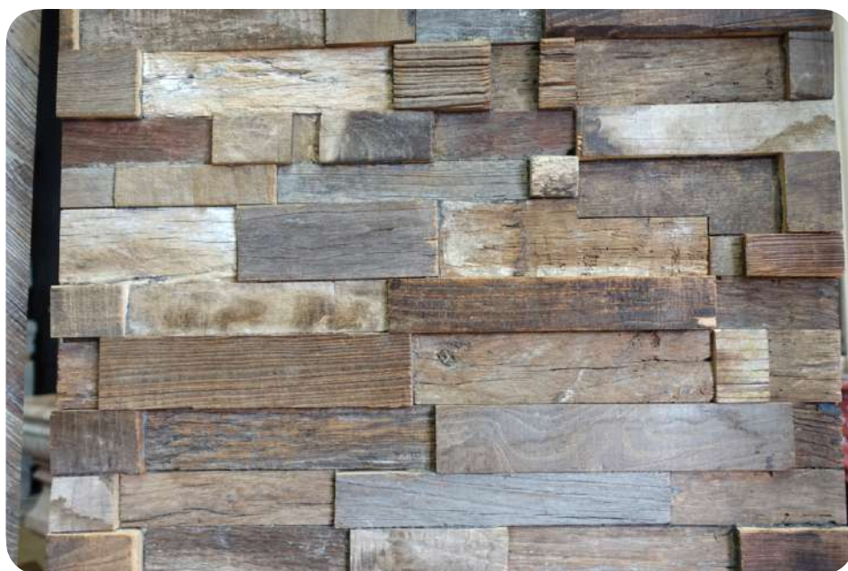
Lambrissage intérieur multi-essence avec des planches de dimensions variables.
