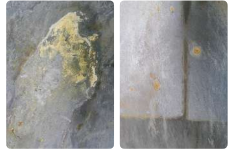
Inclusions minérales et traces de rouilles.
