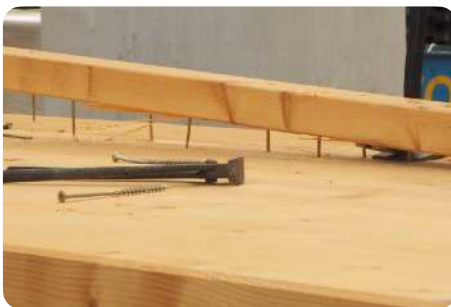
Retrait des éléments métalliques
