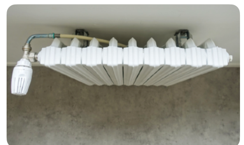
Caserne de Reuilly, Paris Habitat (FR) - Hergebruik in situ van 85 gietijzeren radiatoren. © Rotor en Sixième Continent
