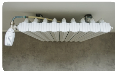
Caserne de Reuilly, Paris Habitat - Réutilisation in situ de 85 radiateurs en fonte (FR). © ROTOR and SIXIEME CONTINENT
