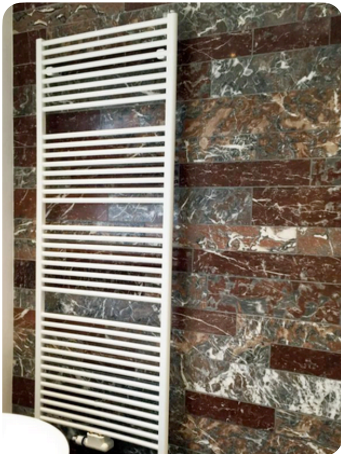
Revêtement mural en tablettes de fenêtrés de réemploi (BE). © Manu Gryson architecte
