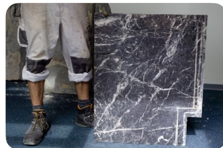
Présence de restes de mastic et d'une découpe pour l'encastrement de la tablette. © Frédéric Uyttenhove
