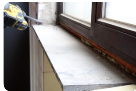
Dégagement des extrémités d'une tablette de fenêtre
