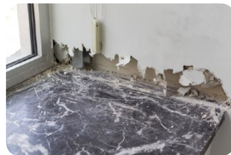
Dégagement des extrémités d'une tablette de fenêtre
