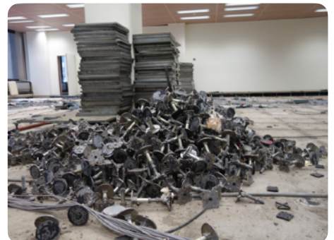
Niet herbruikbare vijzels door aanzienlijke lijmresten.
