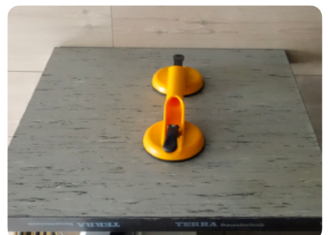
Verwijderen van de tegels met behulp van een zuignap.
