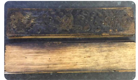
Verwijderen van bitumineuze lijmrresten © www.parquetbitumenremoval.co.uk
