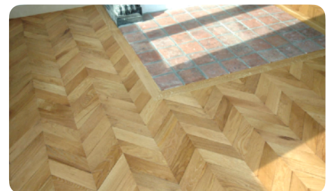
Hergebruik van 50 m 2 parket in visgraatmotief. De planken werden in de dikte doorgezaagd om de oude bitumenlijm te verwijderen. Daarna werden ze bewerkt om in Hongaarse punt te worden geplaatst (gelijmde plaatsing), Boom, België © Atelier Passe Partout
