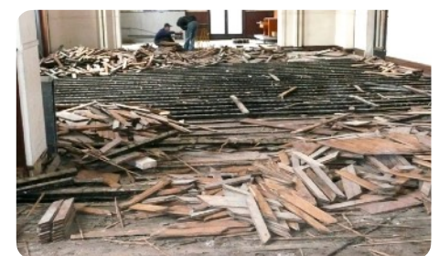
Demontage van een op lambourdes vernagelde parketvloer
