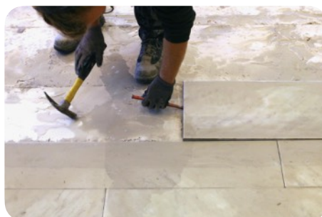
Dépose soignée des dalles
