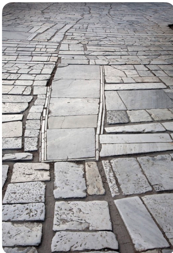
Dallage en pierre de réemploi sur le chemin de l'Acropole d'Athènes (GR), 1930. Pikionis © Mayte Piera
