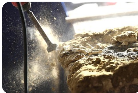
Retrait des résidus de mortier au moyen d'un burin pneumatique © De Opkamer
