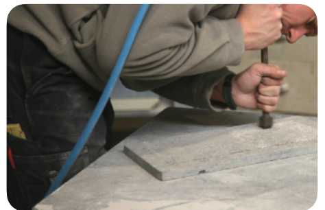
Bouchardage des dalles
