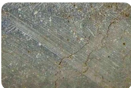
Fissures superficielles
