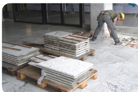
Tri des dalles
