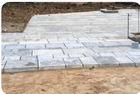
Dalle sur lit de sable © Perrine Henault, Atelier NOUS
