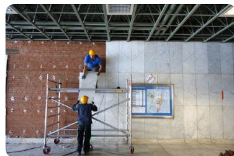
Dépose de dalles en marbre
