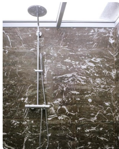
Salle de douche réalisée en marbre rouge de réemploi, Bruxelles (BE) © Séverin Malaud
