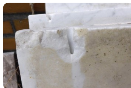
Trou d'ergot élargi lors de la dépose
