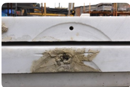
Au-dessus : trou d'ergot intact En-dessous : trou d'ergot comblé de mortier
