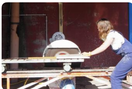
Retrait des résidus de mortier de jointoyage sur la tranche au moyen d'un lapidaire
