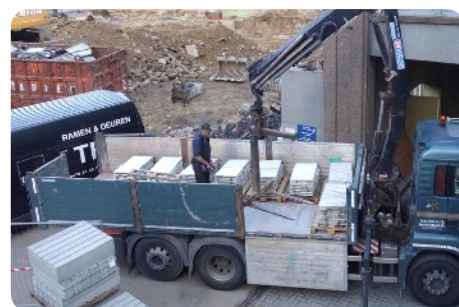
Chargement et transport des dalles
