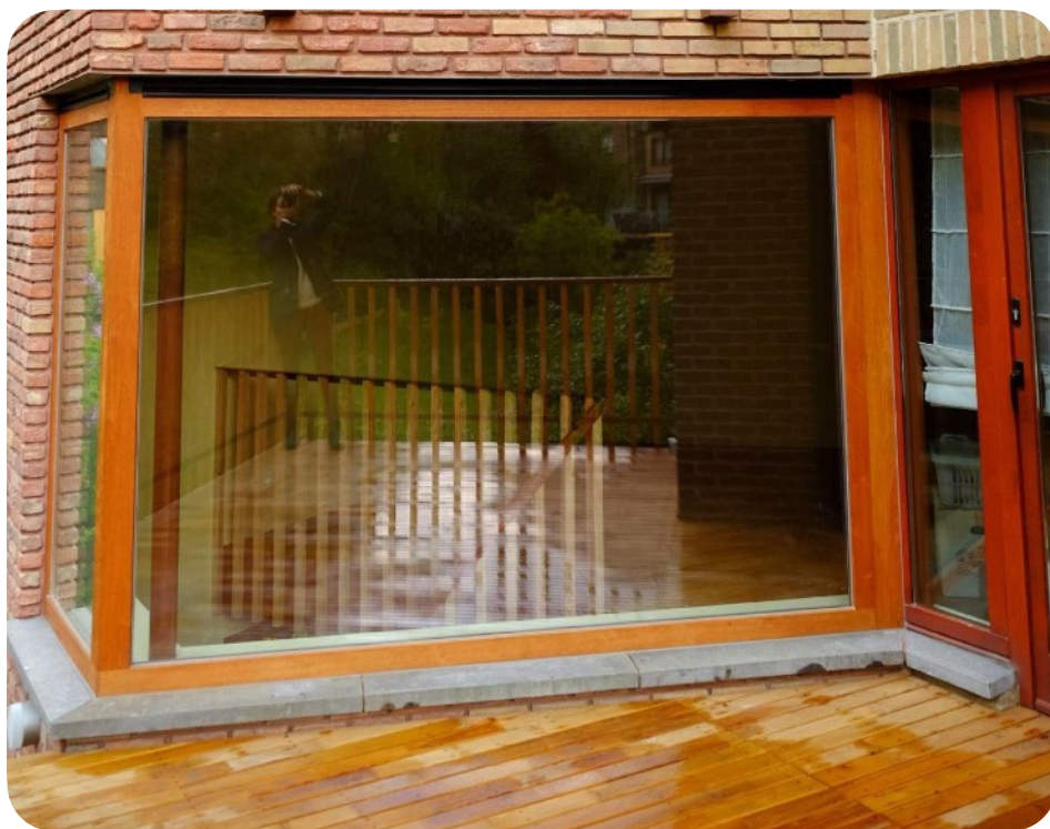
Réutilisation d'anciens couvre-murs en seuil de fenêtres © Sophie Boone
