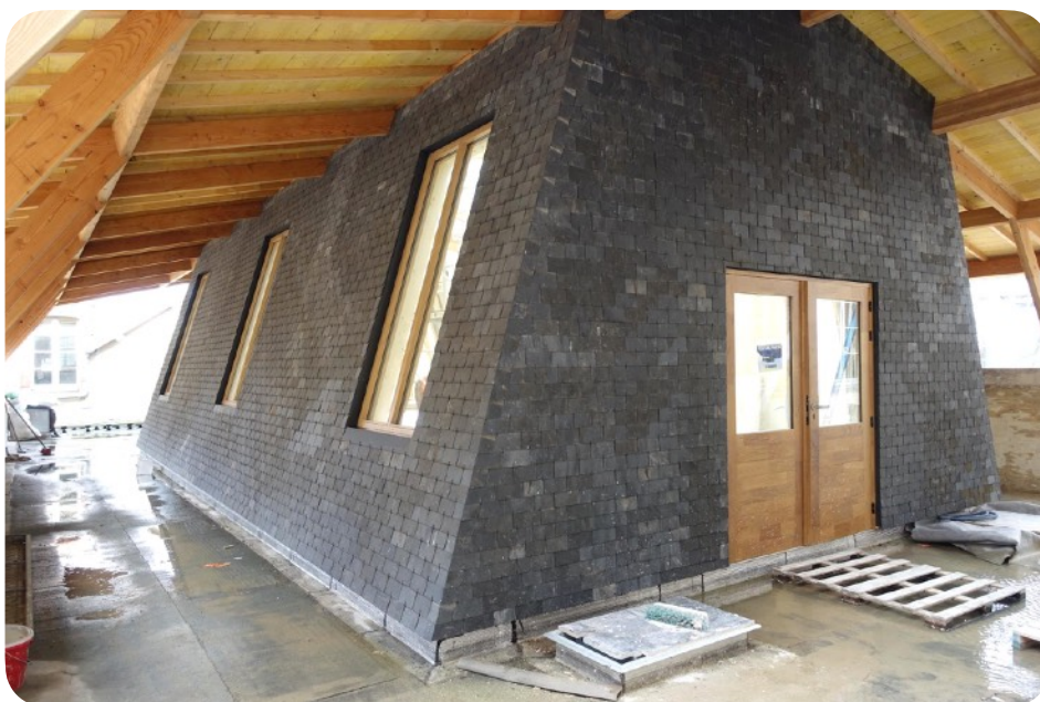
Hergebruikleien als binnenmuurbekleding, Hôtel Pasteur (FR) © Encore Heureux architectes
