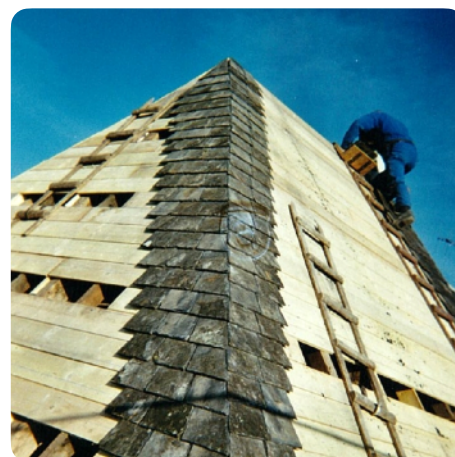
Gehaakte plaatsing van hergebruikleien, dik model met variërende leihogte en breedte (FR) © Sarl Ritouet
