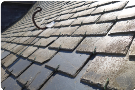
'Originele' en 'reparatieleien'
