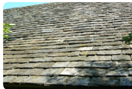
Genagelde plaatsing van hergebruikleien, dik model met variërende leihogte en breedte (FR) © Sarl Ritouet
