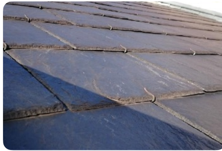
Hook installation, Caserne de Reuilly, Paris (FR)
