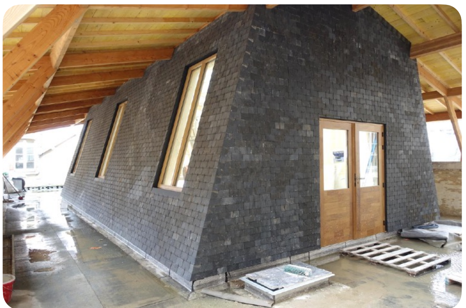
Slates reused as wall covering inside, Hôtel Pasteur (FR) © Encore Heureux architectes
