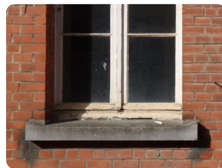
Seuil de fenêtre en pierre bleue (pierre calcaire)
