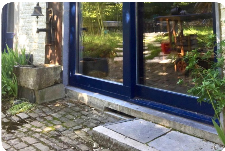
Inspiration réemploi. Seuil de châssis coulissant composé de deux anciens seuils de fenêtres coupés à dimension et taillés pour réaliser une ventilation de la cave (trou au centre) © Sophie Boone
