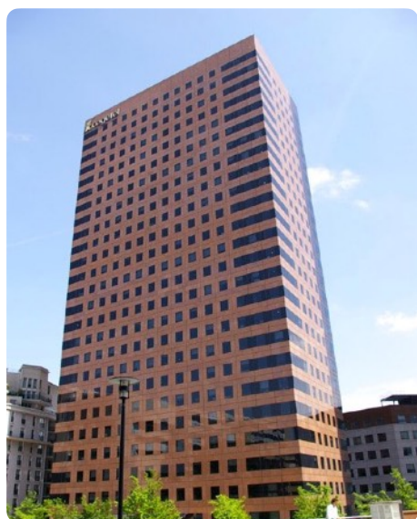
Recuperatie van 5.300 m 2 natuursteenplaten van rood graniet afkomstig van de gevels van de Tour Cèdre in La Défense, Parijs (FR). © Incomex http://pierre-reemploi.com/offre/granit-rouge-de-facade-nr01/
