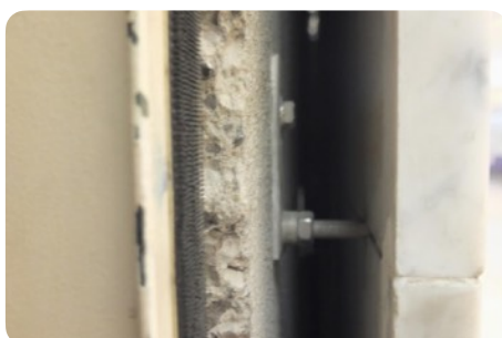
Mechanisch bevestigde natuursteenbekleding
