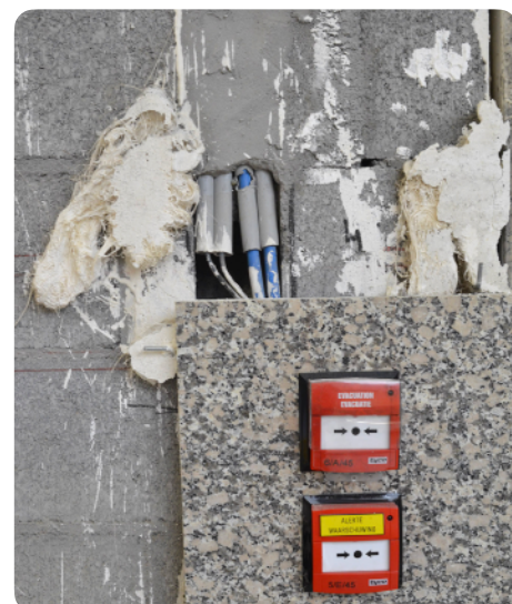
Demontage van platen in graniet voor binnenmuurbekleding
