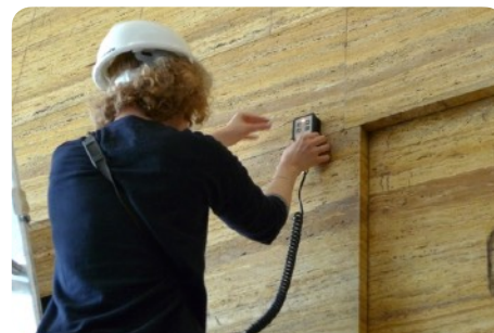
Opsporen van de metalen ankers van een natuursteenbekleding met behulp van een pacometer © WTCB
