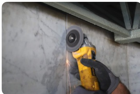
Doorslijpen van de bevestigingsmiddelen
