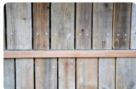
Installatie van 2600 m 2 gevelbekleding van barnwood uit Oost-Europa, Instituut voor Plantkunde van de ULg, Luik (BE). © André Warnier
