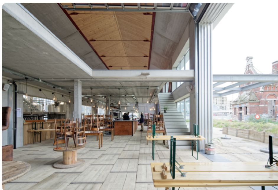
Hergebruik van steenschotten als vloerbekleding en terrasvloeren. Brasserie de la Senne, Brussels (BE). Architect: Générale. © François Lichtlé.
